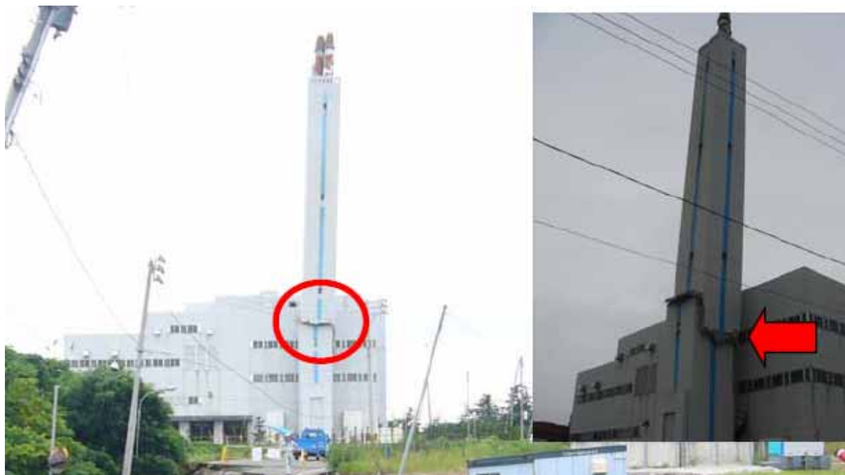
柏崎市のゴミ処理施設 (クリーンセンター) の被災
