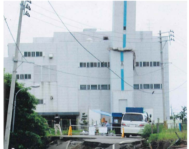
柏崎市のゴミ処理施設(クリーンセンター)の被災
