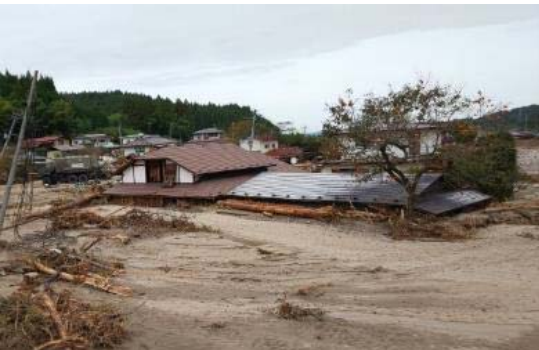
五福谷川による土砂流出状況
