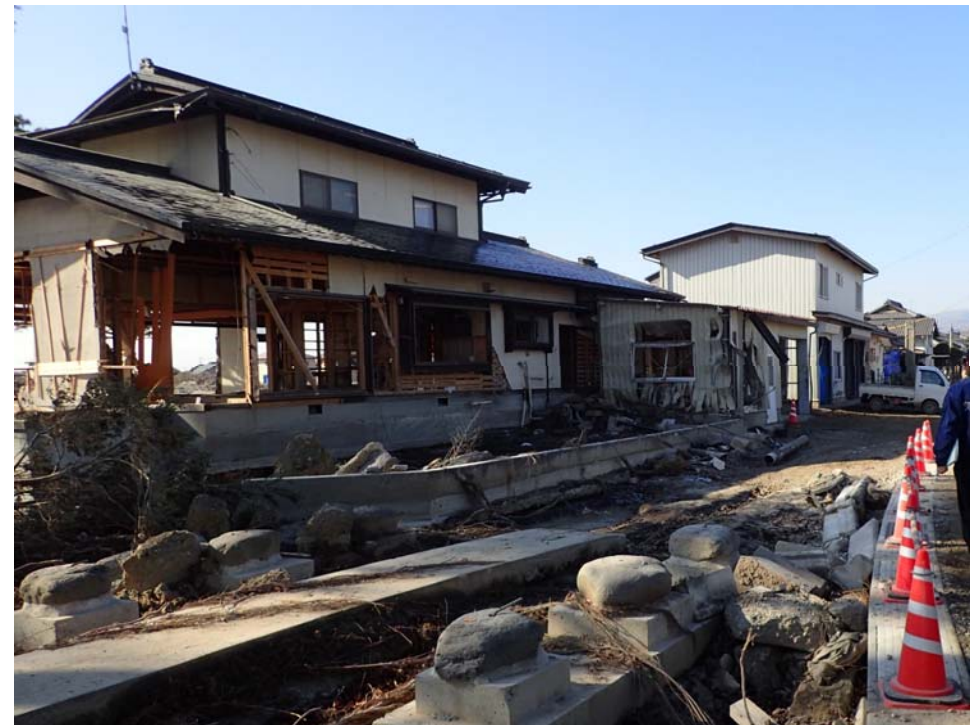
氾濫流による建物崩壊(長沼地区)
