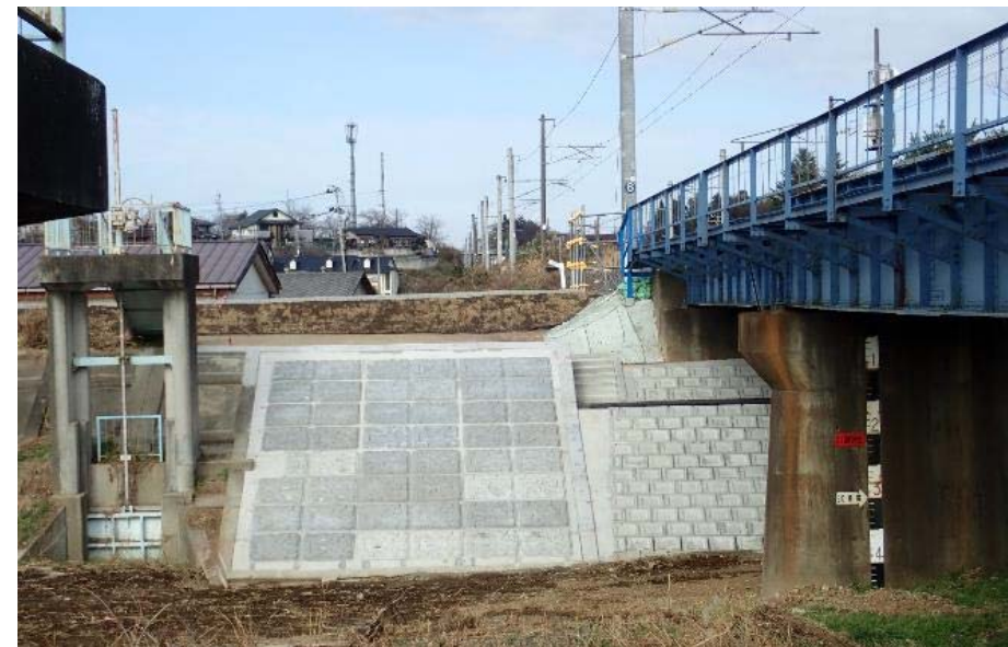
安達太良川の堤防天端崩壊(復旧後)
