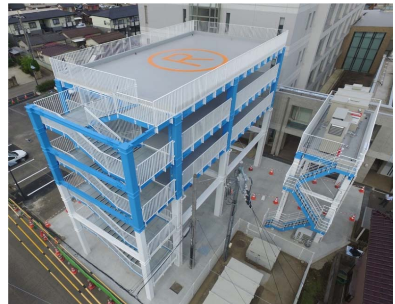
境町水害避難タワー
