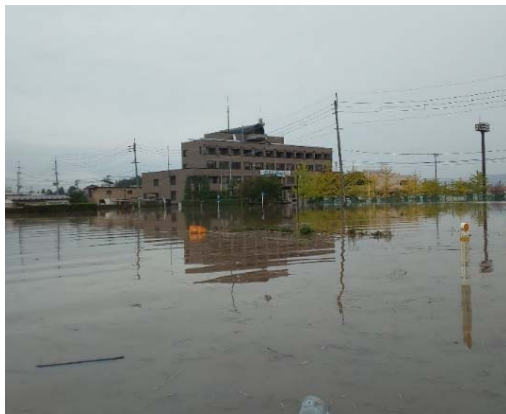
宮城県丸森町 被災状況
