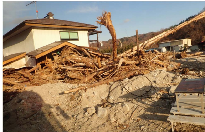
土砂や流木により被災した家屋(五福谷地区)
