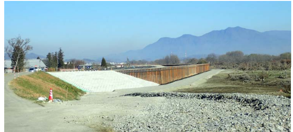
堤防決壊地点の復旧状況(穂保地区)
