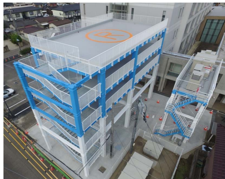
境町水害避難タワー
