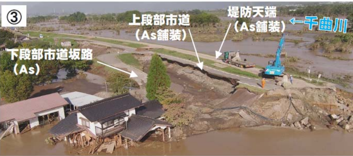
千曲川堤防決壊(穂保地区) 出典:第2回千曲川堤防調査委員会資料
