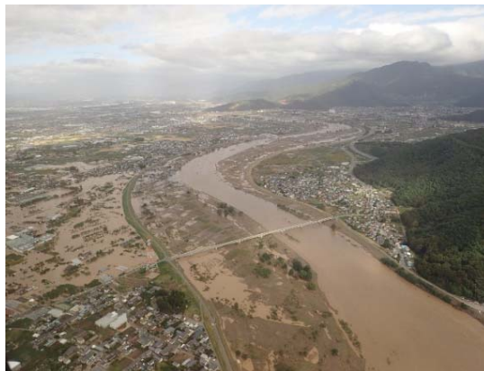
長野県長野市 被災状況
