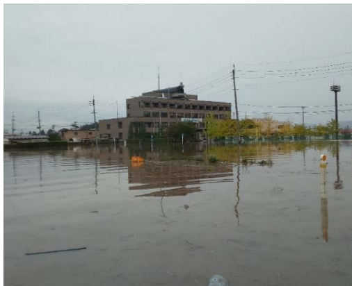
宮城県丸森町 被災状況
