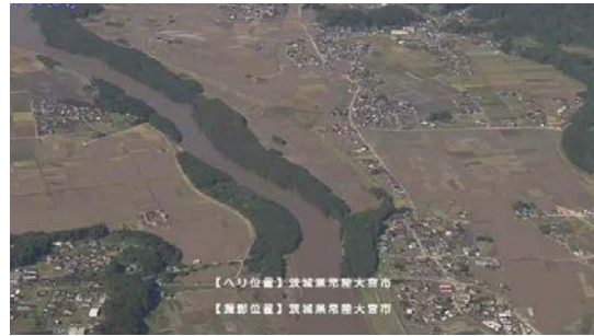
久慈川堤防決壊による浸水状況 (茨城県常陸大宮市)
