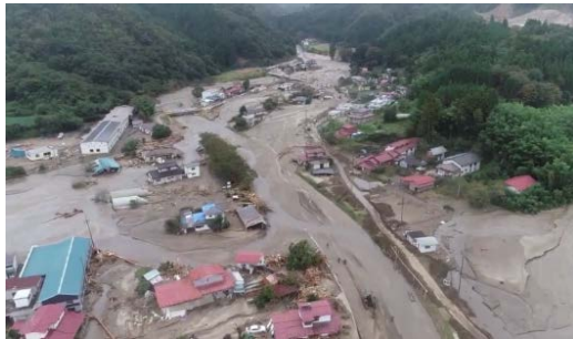
五福谷川の土砂流出状況 (宮城県丸森町)
