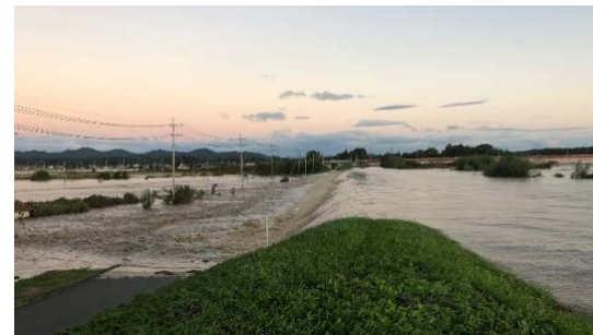
那珂川堤防決壊による浸水状況 (茨城県那珂市)
