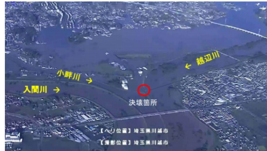
越辺川堤防決壊による浸水状況 (埼玉県川越市)
