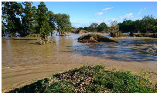
都幾川堤防決壊地点による氾濫状況 (埼玉県東松山市)
