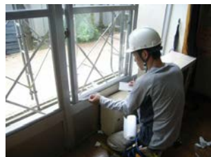
飛散防止フィルムの 工事の様子
