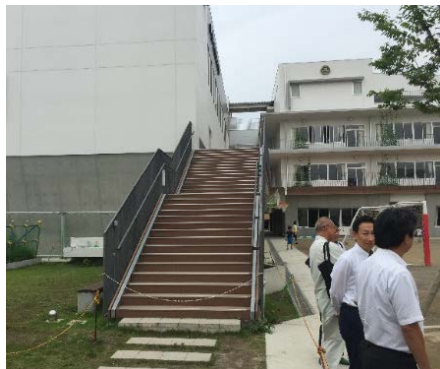
体育館と校舎に接続している階段
