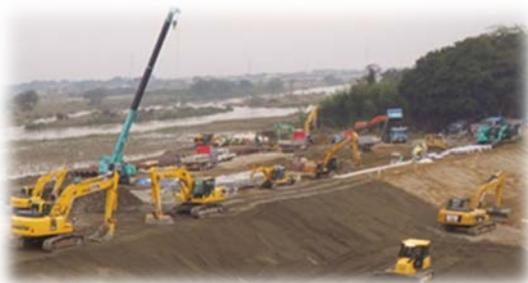
写真 13 国土交通省による堤防の応急復旧
