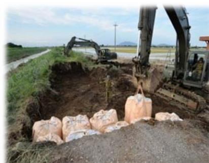
写真 15、16 自衛隊による水防活動（土のう積み）
