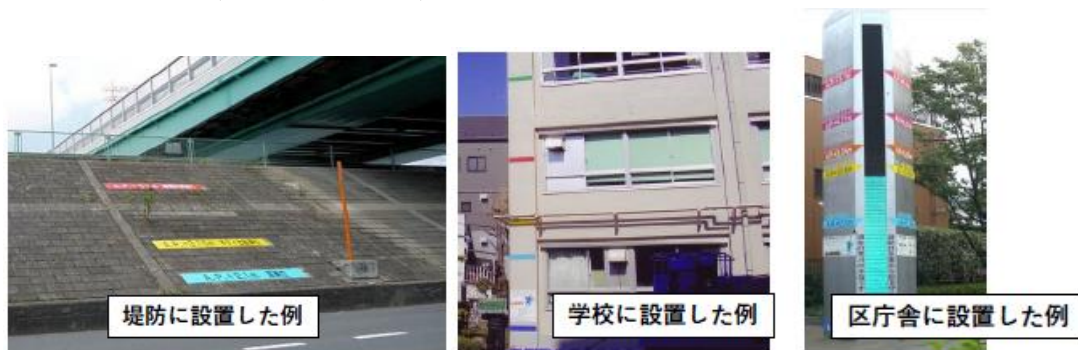
図表 59 浸水深表示板の設置例（東京都江戸川区）
