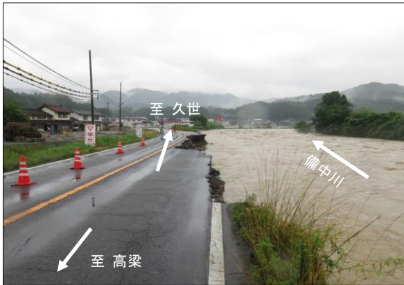
国道313号 (真庭市下方)
