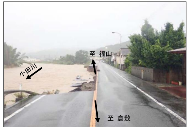
国道486号 (井原市西江原町)
