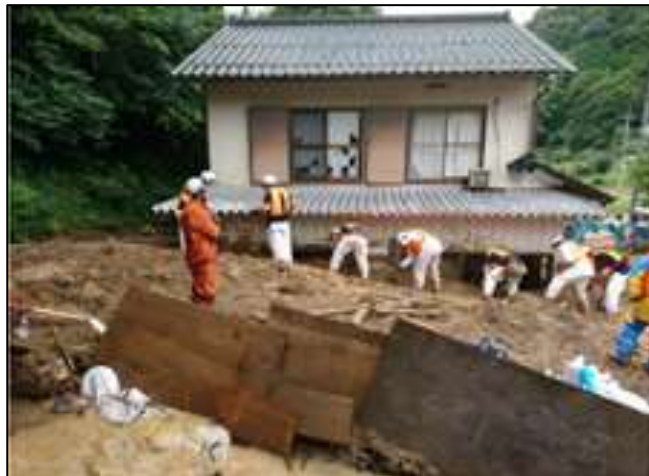
←舞鶴市城屋の土砂崩れ現場 (1名が死亡)
