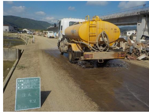
散水車による路面散水
