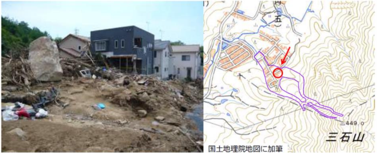
写真 3-3-5-3 最上部の住宅の被災状況
