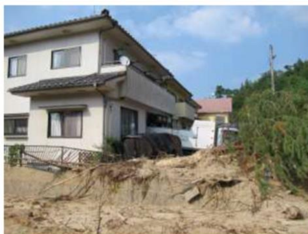
写真 3-3-5-12 南側の住宅の被災状況
