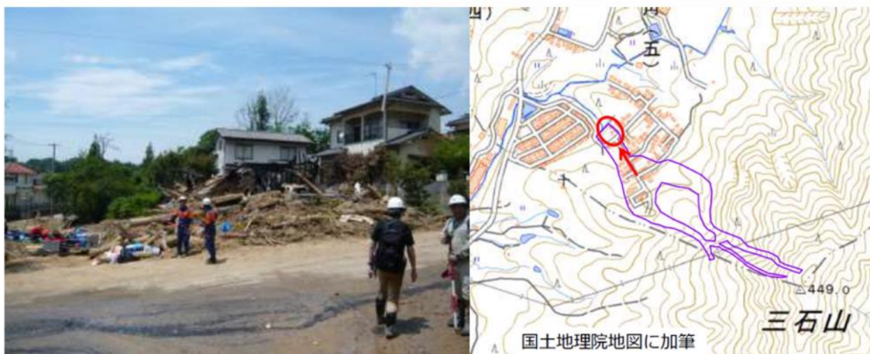
写真 3-3-5-13 住宅地出入口の被災状況
