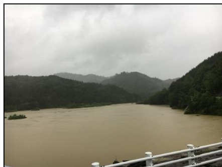
7月豪雨時の宮川防災ダム
