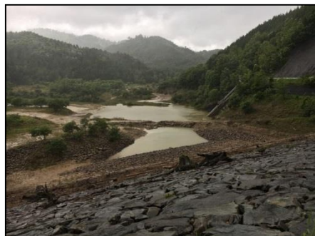
平常時の宮川防災ダム
