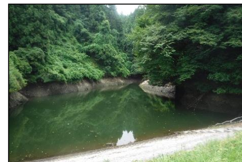
防災重点ため池 (緊急点検時)
