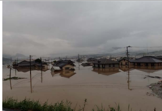
浸水被害 (岡山県倉敷市真備町)
