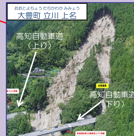
高知県 林地荒廃 133か所 治山施設 6か所
