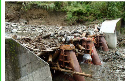
(参考)流木捕捉式治山ダムによる土石・流木捕捉の例
