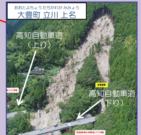
高知県 林地荒廃 129か所 治山施設 6か所
