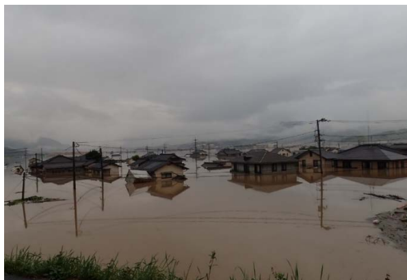
浸水被害 (岡山県倉敷市真備町)
