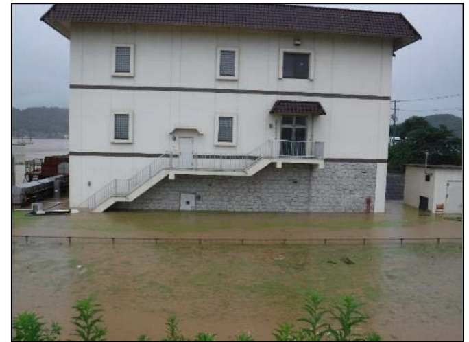
約1.4m浸水（三原市本郷第2ポンプ場）
