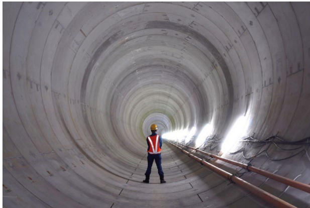
名古屋中央雨水調整池
