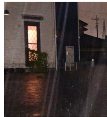
住家被害(床上浸水)
