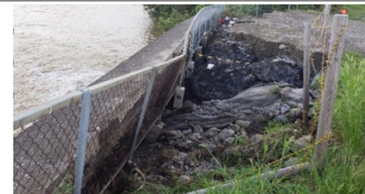
農業用堰 護岸の崩落 (市原市)
