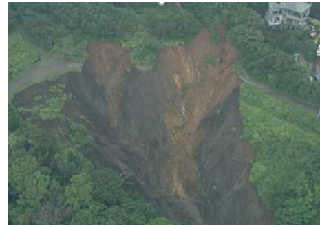
土石流による被害（静岡県熱海市）
