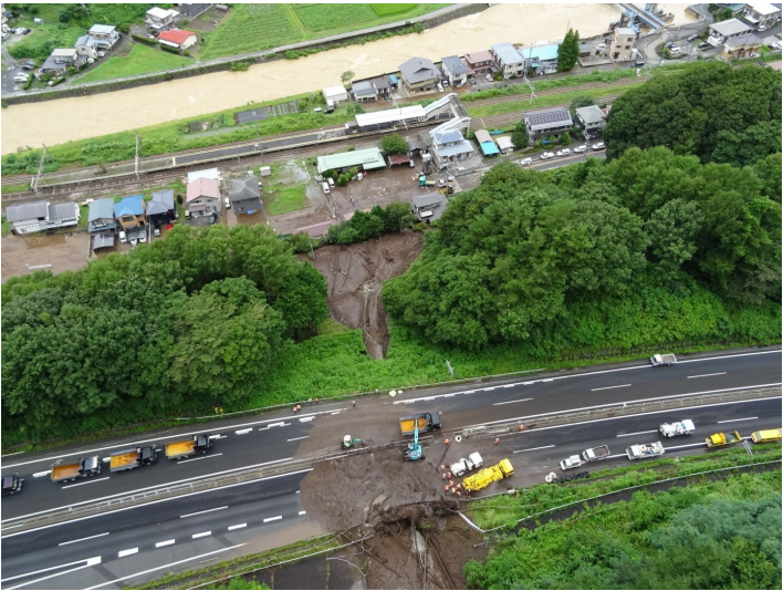
土石流による被害（長野県岡谷市）
