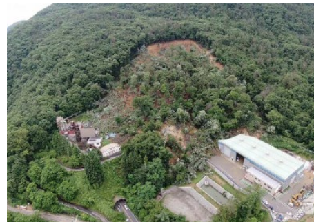
地すべりによる被害（長野県長野市）
