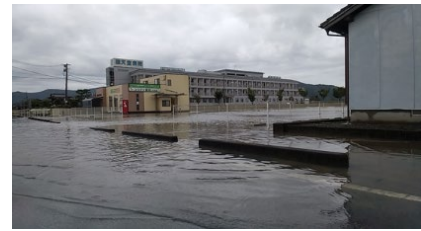
六角川水系六角川における 浸水被害（佐賀県武雄市）
