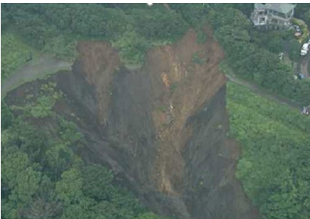
伊豆山地区での土石流による被害 (静岡県熱海市)
