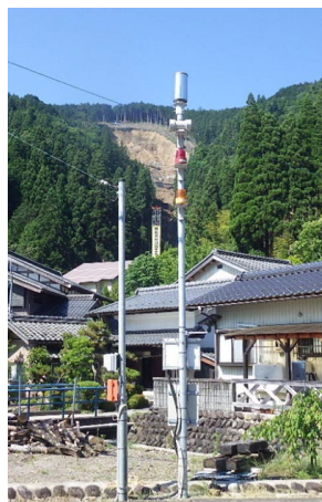
設置したサイレン
