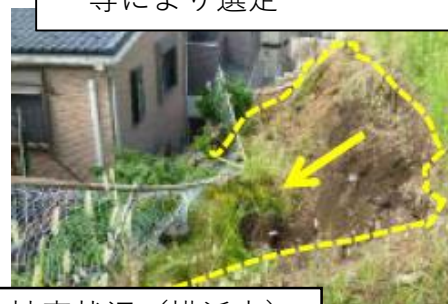
平成26年台風第18号の被害状況（横浜市）
