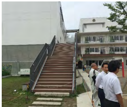
体育館と校舎に接続している階段
