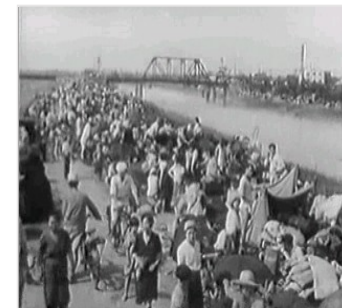
江戸川堤防の雑踏状況(関東地方の水害(映画新社)より)
