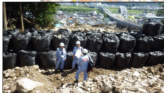
大型土のう設置状況
