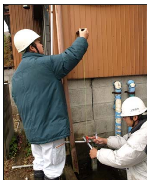
(住宅の傾斜の計測)
