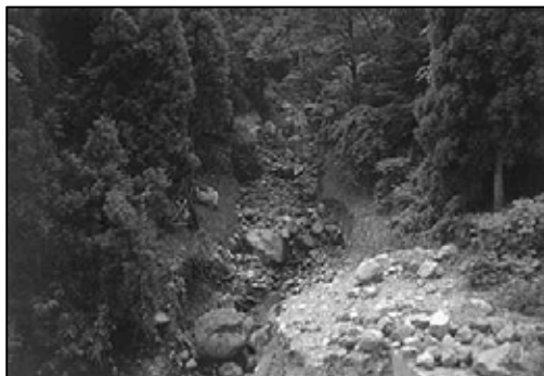
写真 1 福井市蔵作町稗苗川上流崩壊
