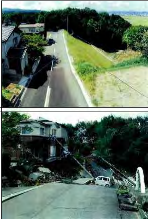
写真 被害の状況
