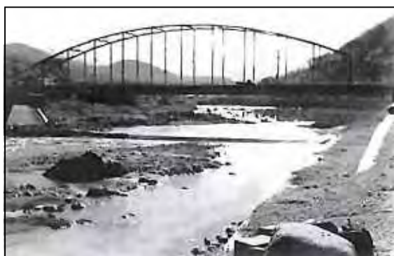
写真 復旧事例(左：狩野川堤防、右：災害の教訓を生かした橋脚なしの橋)
