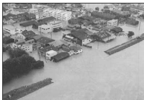
写真1 新川破堤箇所（西区あし原町）
