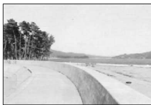
写真 復旧後の防波堤(高田海岸・左：第一線堤、右：第二線堤)
