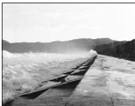
写真 復旧後の防波堤(高田海岸・左：第一線堤、右：第二線堤)
