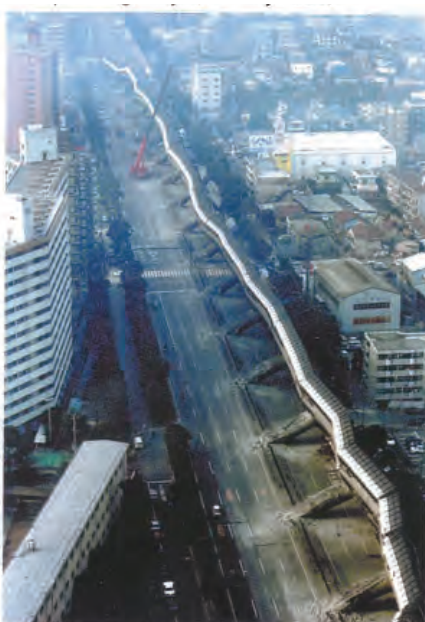
高速道路の崩壊(平成7年1月) 고속도로 붕괴(1995년 1월)
