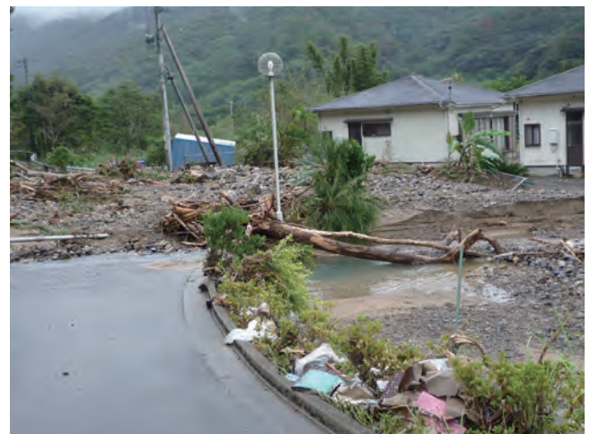
(平成 22 年 10 月奄美地方豪雨) 鹿児島県奄美市住用町の被害状況
