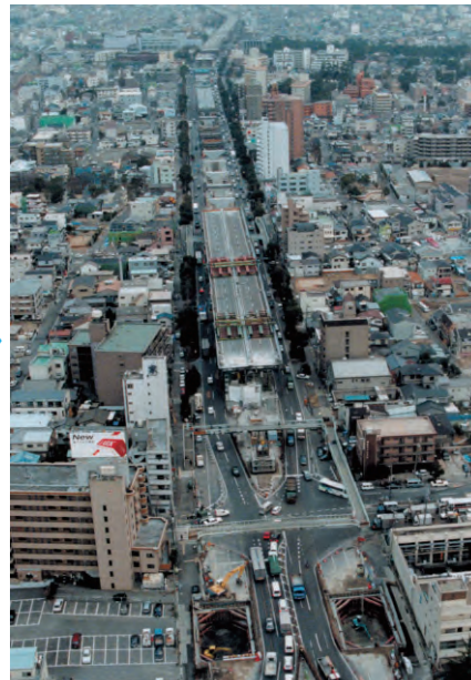
高速道路の復旧工事 고속도로 복구공사
