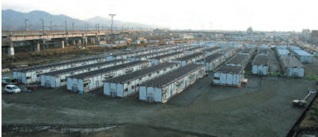
新潟県中越地震時の応急仮設住宅 니가타현 추에쓰 지진 발생시의 응급 가설주택
