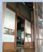
耐震補強工事の一例 내진보강공사의 사례
