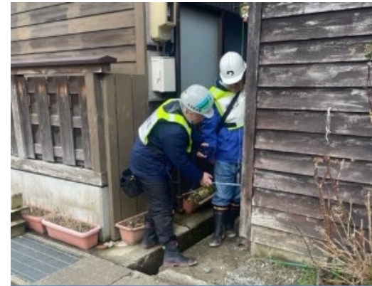
建物被害認定調査 (石川県輪島市)
