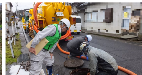
農業集落排水施設の点検
