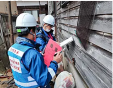
被災建築物応急危険度判定 (石川県穴水市)
