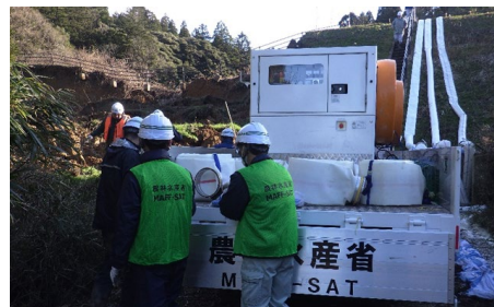
被災ため池への災害応急用ポンプ車の派遣
