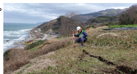
地質官（農林水産省職員）による現地調査（輪島市稲舟地区）
