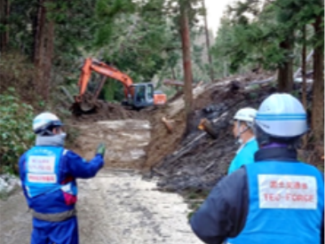
建設業者と連携した道路の緊急復旧 (石川県輪島市)
