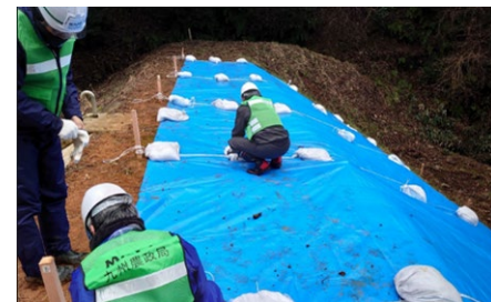
被災ため池におけるブルーシートの設置
