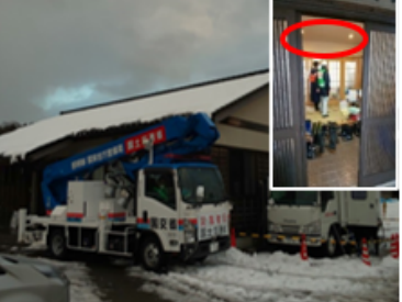
避難所へ照明車からの電源支援 (石川県輪島市)
