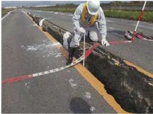
写真 1-31. 比較的大きい堤体の変状
