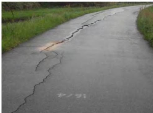
写真 1-33. 堤防天端のひび割れ
