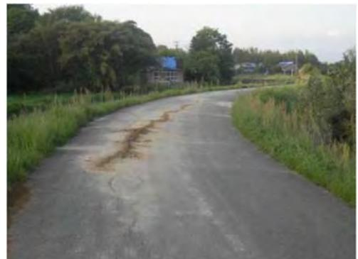
写真 1-34. 応急対策完了（セメントミルク注入）
