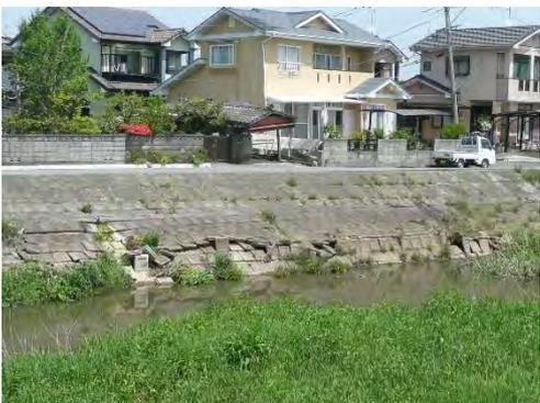
写真 1-35. 護岸の損傷
