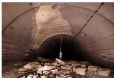
写真 1-21. 覆工コンクリートの崩落(俵山トンネル)
