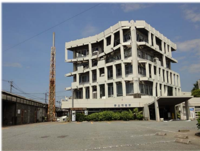
【宇土市役所の被災状況】
