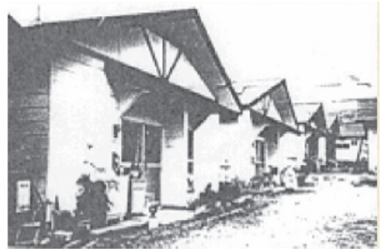
改修後の住宅の外観（浅野弥三氏提供） 出典：阪神大震災復興市民まちづくり支援ネットワーク事務局『きんもくせい32号』平成8年7月
