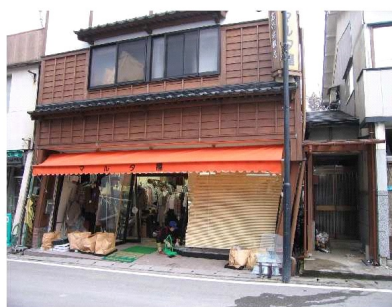
修復前（全壊判定）
