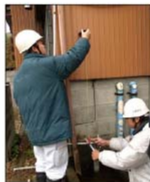
(住宅の傾斜の計測)
