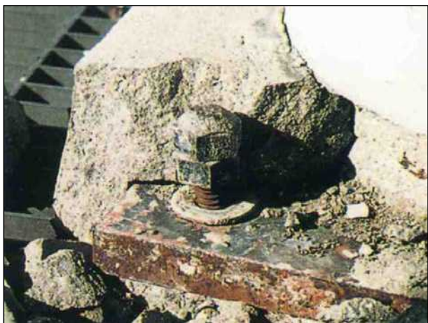
アンカーボルトの伸びが見られる。
