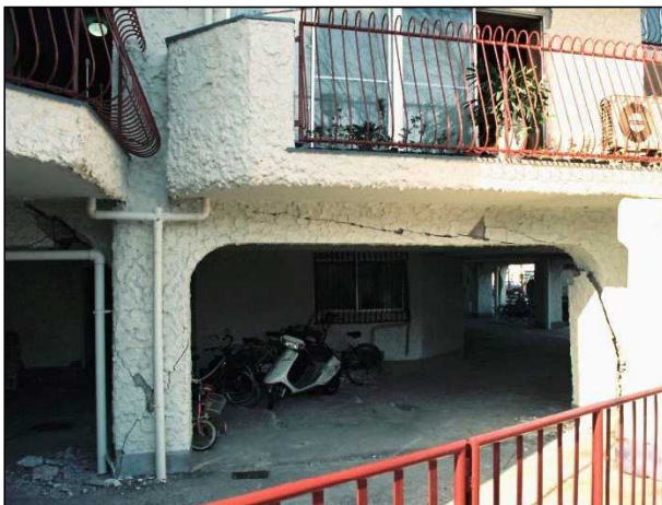
被害の最も大きい階が柱の場合(ピロティ形式)
