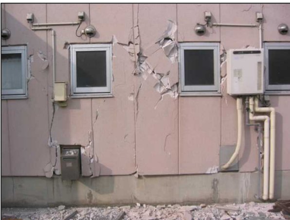
【外部仕上】 9305 大きなひび割れ又は仕上の剥離が見られる。
