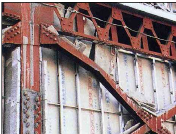
【鉄骨造】 座屈変形が見られる。
