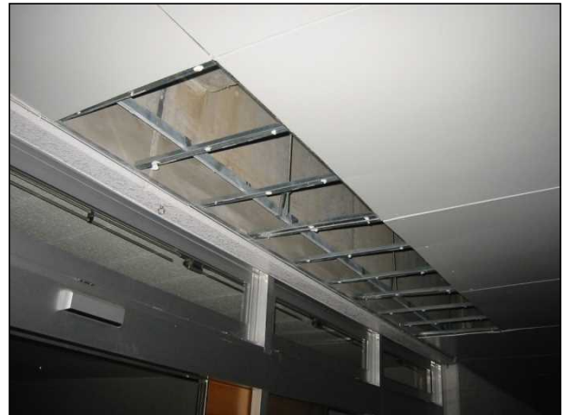
【天井】 9604 天井板が脱落している。
