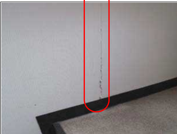
【内部仕上】 ボードの目地部にひび割れやずれが生じている。 9503
