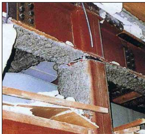
接合部の破断が見られる。
