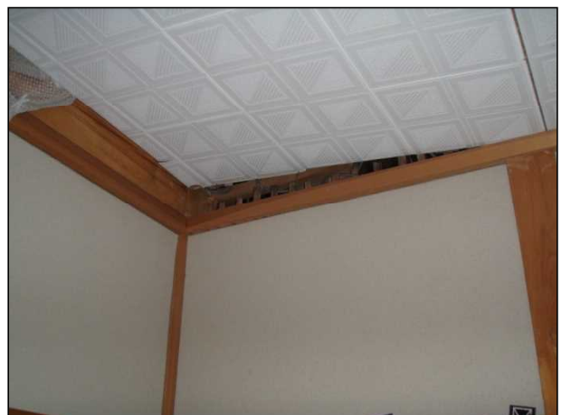
【天井】 天井板の浮きが生じている。 9506
