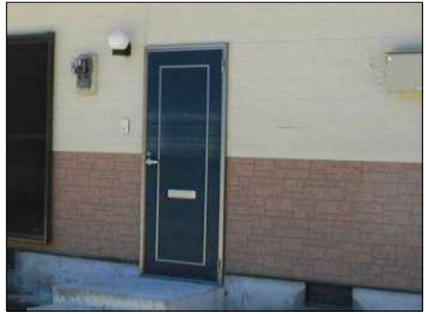
【ドア】 9702 浸水によるドアの破損(表面、格子・縁の洗浄によって、再使用が可能な程度)
