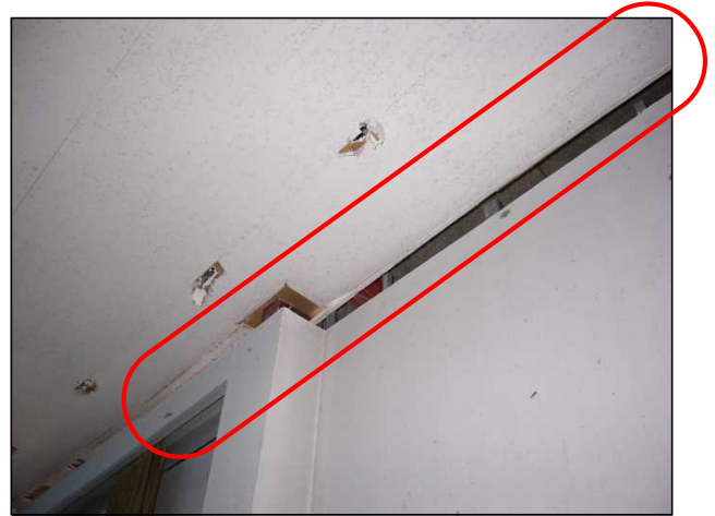
【天井】 9602 天井板のずれが見られる。
