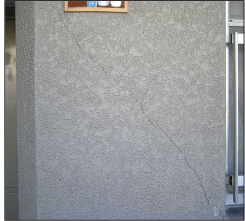
【雑壁】 9302 一部にひび割れ(幅約0.2mm~1mm)やはがれが生じている。
