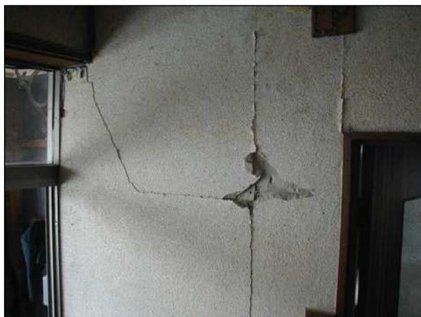
【内部仕上】 クロスが破れている。 9505
