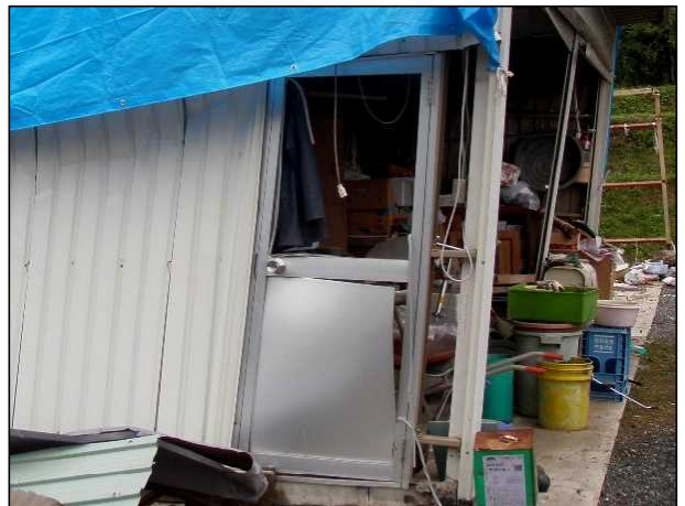
【アルミドア】 破壊されている。
