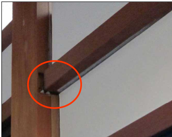
柱と梁の仕口にずれが生じている。
