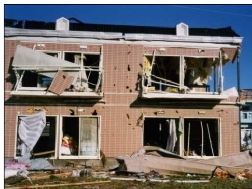
(ベランダ：手摺が破損している。)
