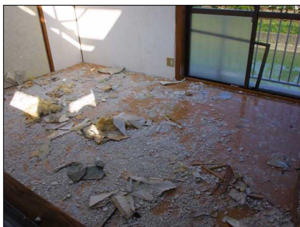
浸水により床板の汚損が見られる。
