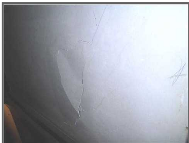
衝突によりへこみが生じている
