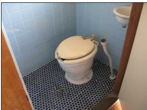
(便器、手洗いの配管が外れている。)
