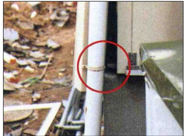
アンカーボルトの伸びが見られる。
