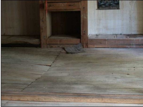
床板に著しい不陸、折損が見られる。
