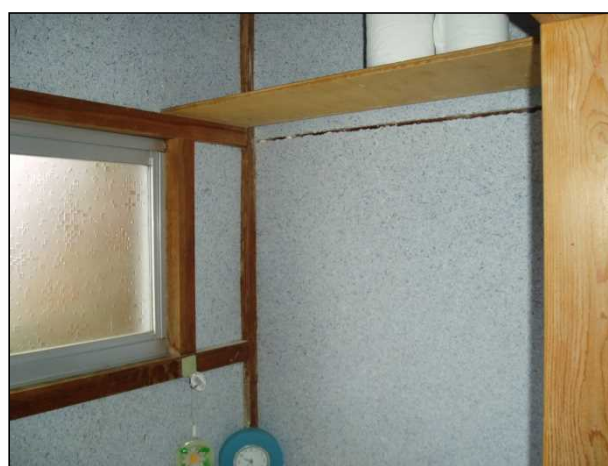
ボードの目地部にひび割れやずれが生じている。
