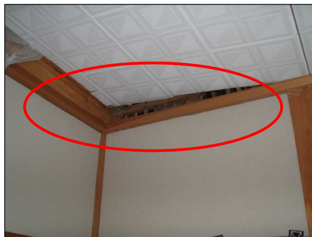
天井板の浮きが生じている。
