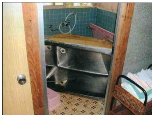
(浴槽：転倒し、配管が切れている。)
