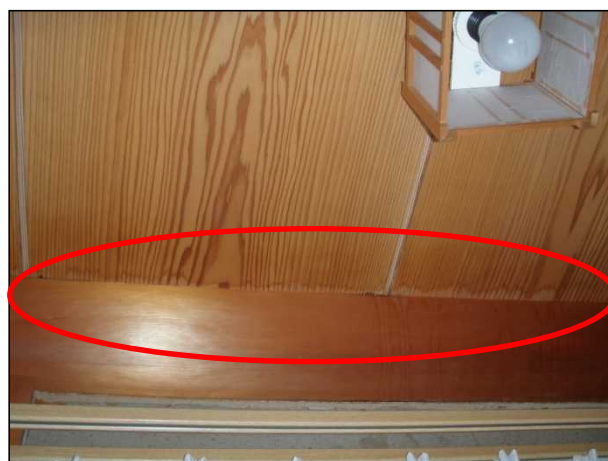
天井板に隙間が生じている。
