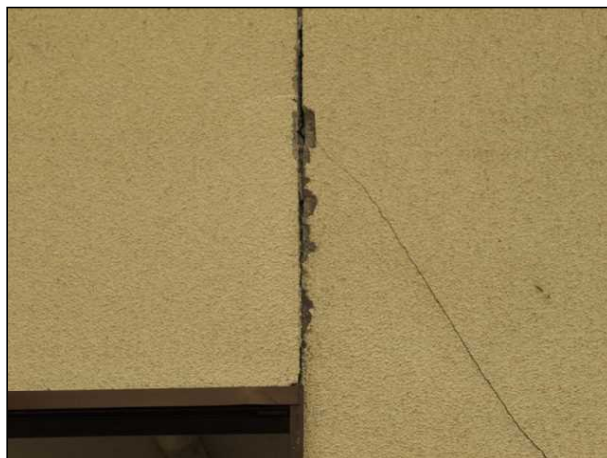
「ボード」目地にわずかなひび割れが生じている。
