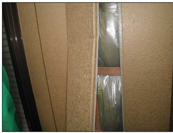
ボード仕上の壁ではボード間に著しいずれが生じている。
