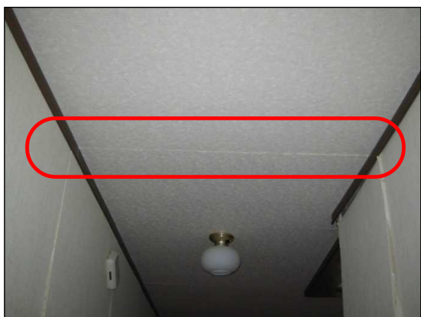
天井板に隙間が生じている。
