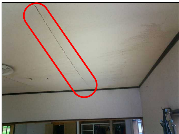
塗天井に亀裂が生じている。
