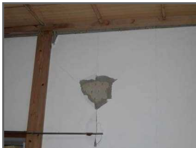
衝突等によりクロスが破れている
