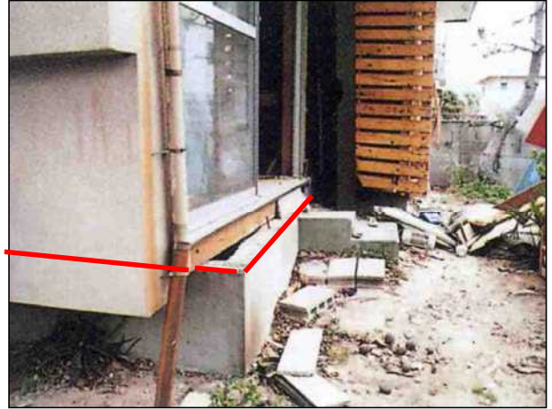
土台が基礎から著しくずれている。
