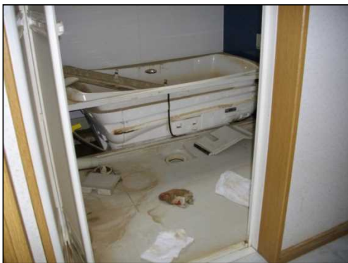
(浴槽：破損している。)
