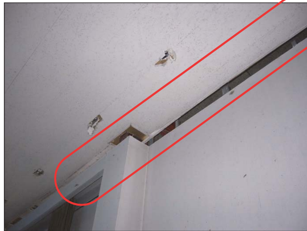
【天井】 天井板のずれが見られる。
