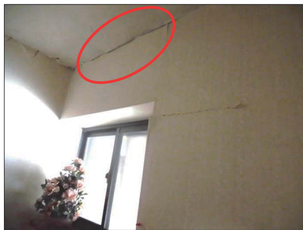
天井板に隙間が生じている。
