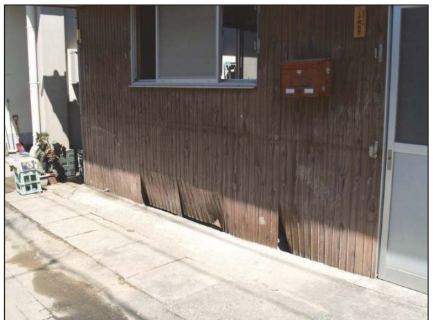
浸水により仕上材の浮き・剥離・脱落が生じている。
