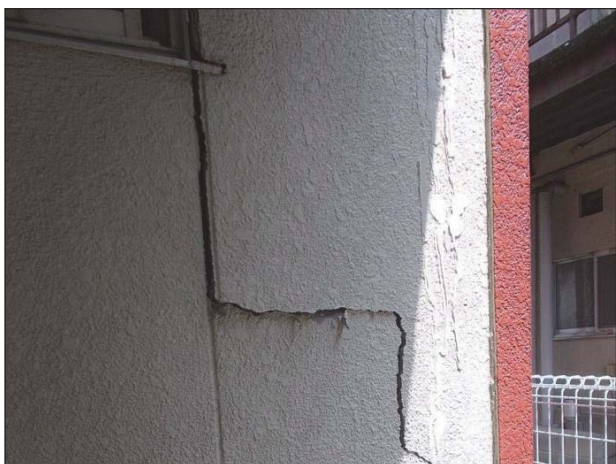
【外部仕上】 仕上やパネルの目地にはっきりとしたひび割れが見られる。仕上材が部分的に剥離している。 50099
