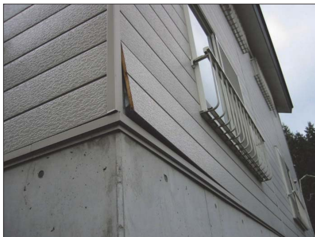
【ホード】 目地部に著しいずれ、面材釘打部の部分的な浮き上がり、ボード隅角部の破損が生じている。
