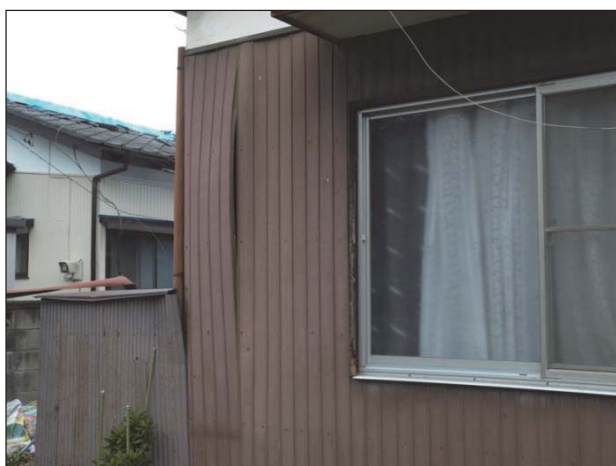
【ホード】 仕上面の目地部にひび割れやずれが生じている。
