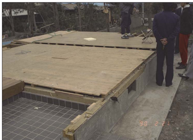
屋根や外壁、床が吹き飛ばされ、床下地、土台などが残る。基礎に被害は見られない。 30005
