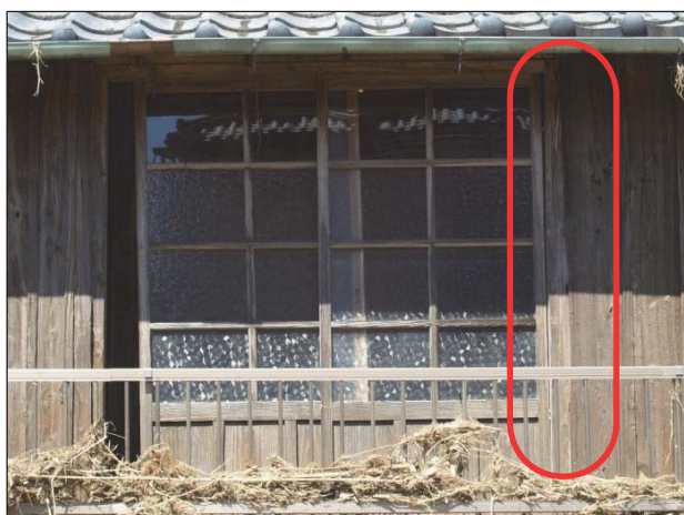
【木製サッシ】 壁面との間に隙間が生じている。
