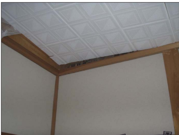
天井板の浮きが生じている。
