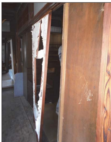
【襖・障子】 可動部が破損しているが、かまちに損傷は見られない。
