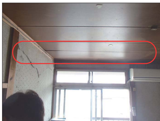
【天井】 天井板に隙間が生じている。
