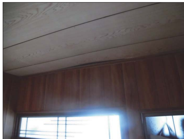
天井板の浮きが生じている。
