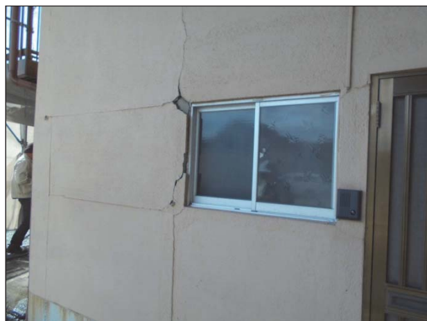
【外部仕上】 仕上やパネルの目地にはっきりとしたひび割れが見られる。仕上材が部分的に剥離している。 50100
