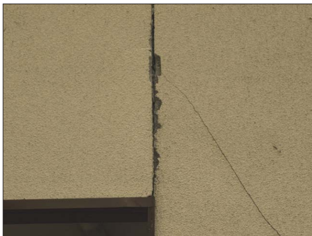
【ホード】 目地部にわずかなずれが生じている。
