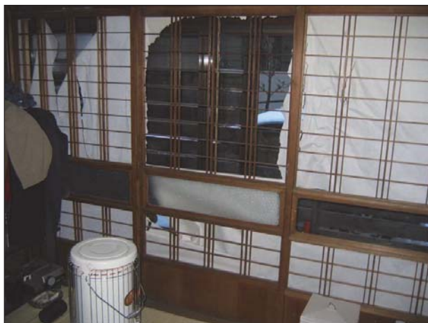
【襖・障子】 家具の倒れ込み等によって襖紙、障子紙が破損し、張り替えが必要である。
