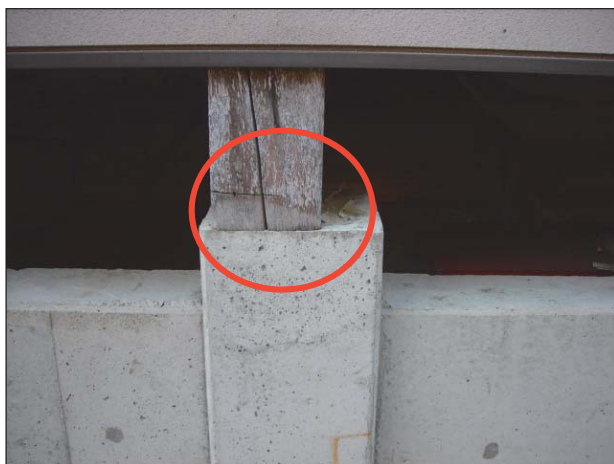
束が束石よりわずかにずれている。
