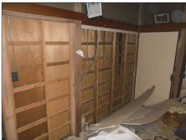
内壁合板に剥離、脱落が見られる。
