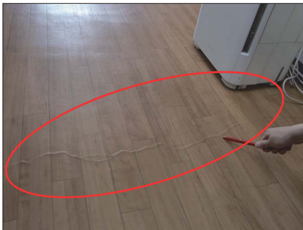
床仕上・畳に損傷が生じている。
