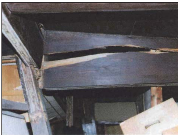
【在来工法】 柱、梁に折損が見られる。
