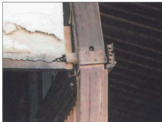
【在来工法】 柱、梁の仕口に著しいずれが見られる。
