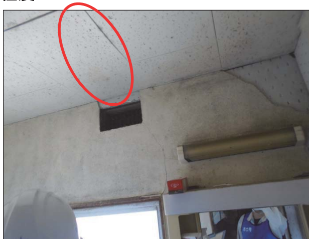
天井板に隙間が生じている。
