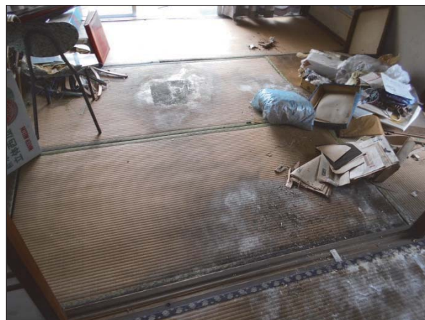
床仕上・畳に著しい損傷が見られる。
