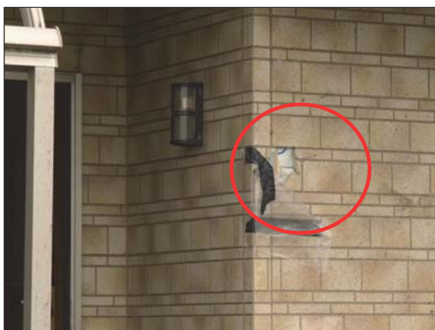
壁に飛来物の軽微な衝突痕がある。
