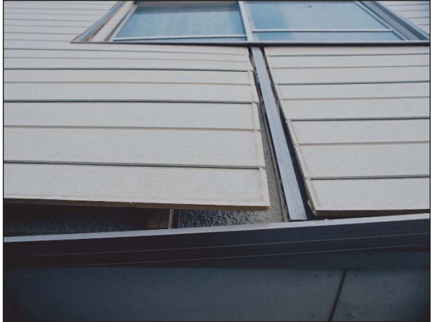
大きなひび割れ又は仕上の剥離が見られる。
