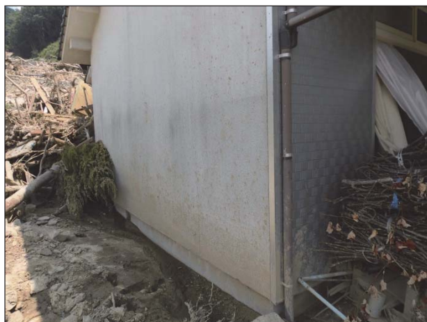
浸水により仕上材の汚損が見られる。
