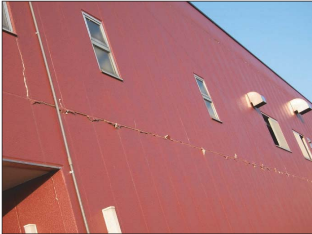
仕上やパネルの目地にはっきりとしたひび割れが見られる。また、仕上材の目地にずれが見られる。
