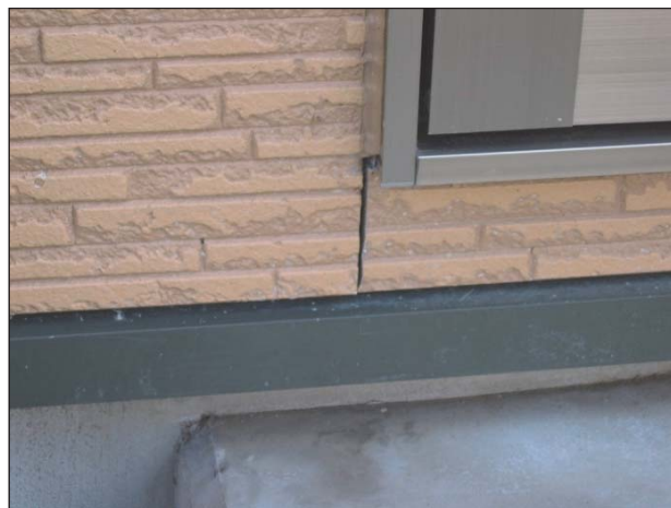
【ホード】 目地部にわずかなずれが生じている。
