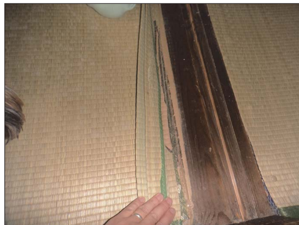
床仕上・畳に損傷が見られる。
