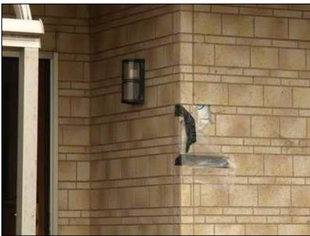
壁に飛来物の軽微な衝突痕がある。
