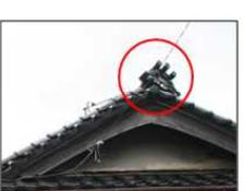
被災(かし)る屋根、のしまの一部がずれ、漏水が生じている。
