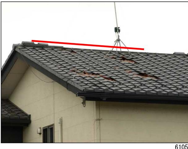
棟瓦が全面的にずれ、破損あるいは落下している。
