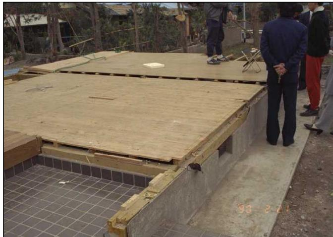
屋根や外壁、床が吹き飛ばされ、床下地、土台などが残る。基礎に 5701
