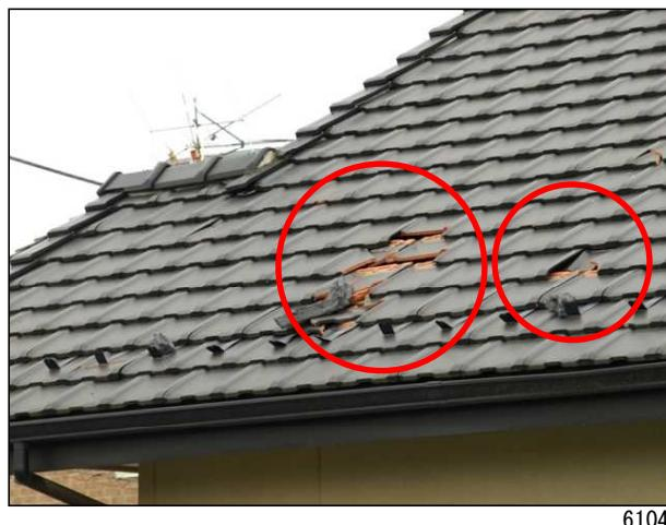
屋根の一部に飛来物による軽微な衝突痕がある。
