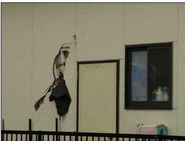
壁の一部に飛来物による突き刺さり、貫通痕がある。
