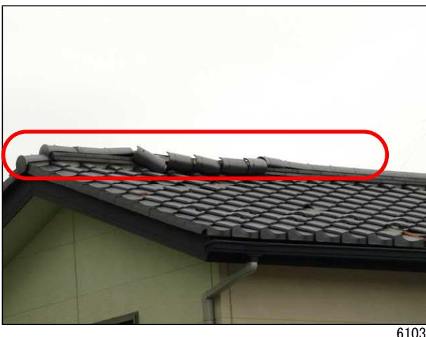
棟瓦のずれ、破損、落下が著しいが、その他の瓦の破損は少ない。
