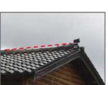
洪水により屋根瓦等に浮きが見られる。
