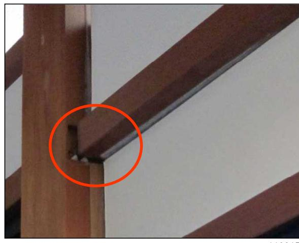
柱と梁の仕口にずれが生じている。
