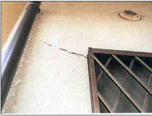
開口隅角部廻りにわずかなひび割れが生じている。
