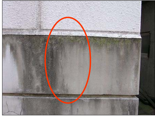
【鉄骨系プレハブ】 柱脚コンクリートのひび割れが見られる。
