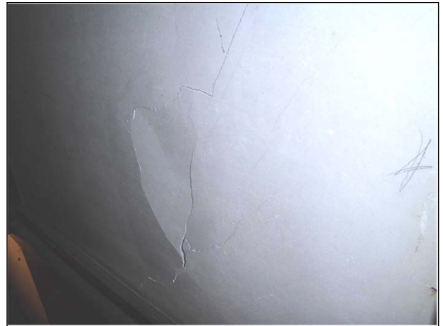
(衝突によりへこみが生じている)
