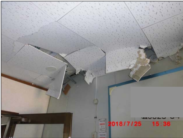
天井板が脱落している。
