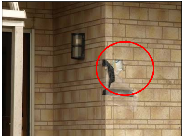
壁に飛来物の軽微な衝突痕がある。
