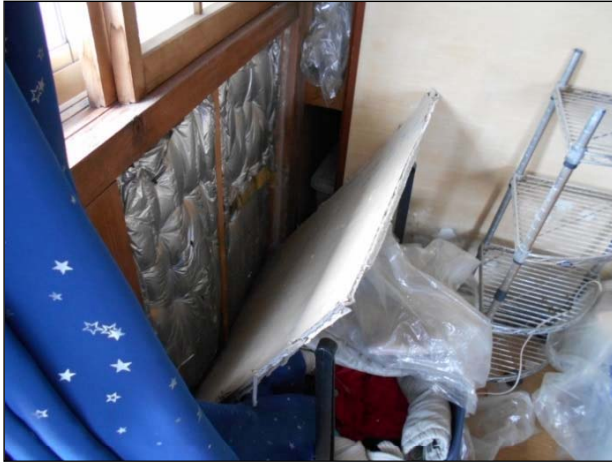
内壁合板に剥離、脱落が見られる。
