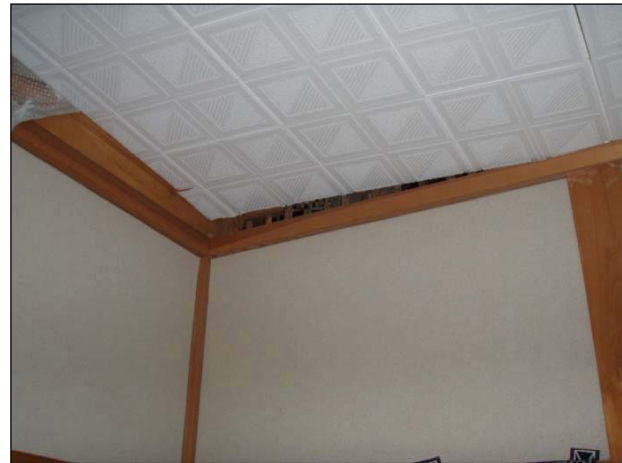
天井板の浮きが生じている。
