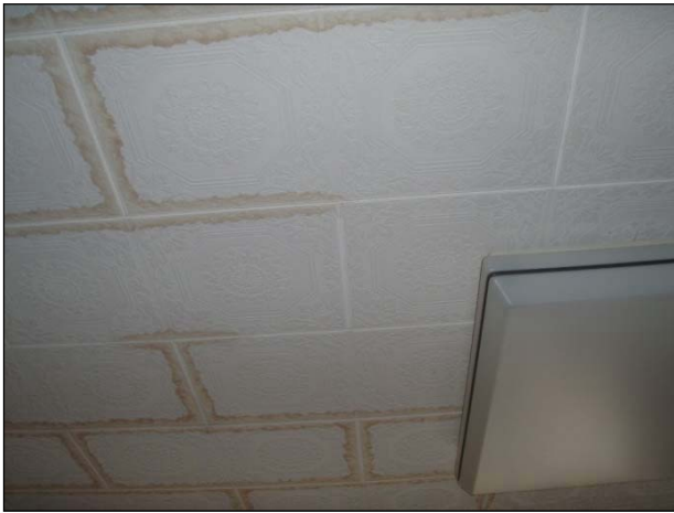
浸水による天井仕上(クロス等)の剥離・表面劣化が見られる。(下地材の交換を要しない程度)
