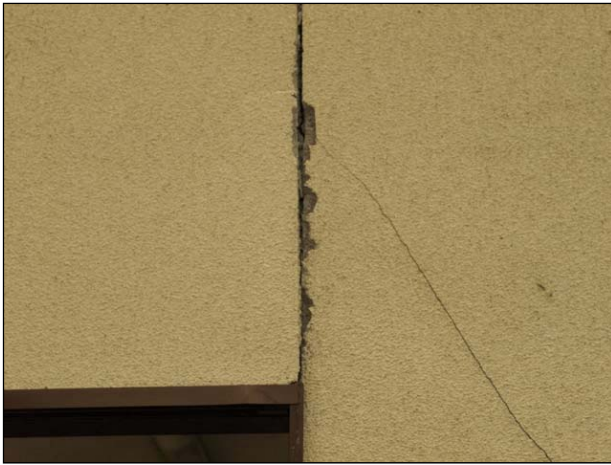
【ホード】 目地部にわずかなずれが生じている。
