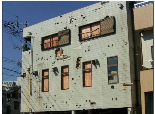
壁の全面にわたって飛来物による衝突痕、突き刺さり、貫通痕がある。
