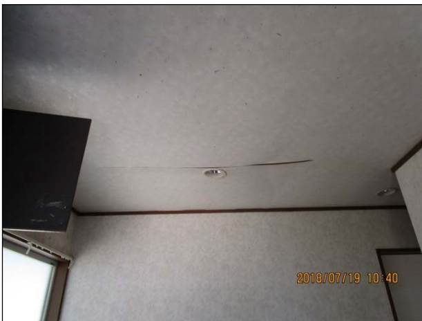
天井板に隙間が生じている。
