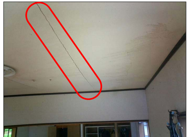
塗天井に亀裂が生じている。
