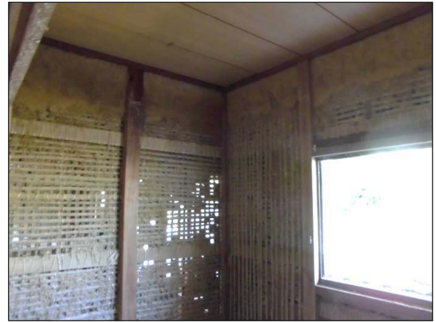
浸水により塗土の大半が剥落している。
