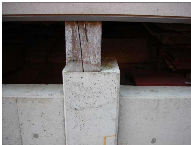
束が束石よりわずかにずれている。
