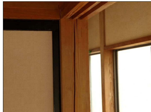
【在来工法】 柱、梁に割れが見られる。
