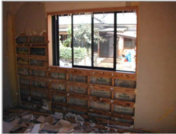
浸水により断熱材の吸水による機能損失が見られる。(再使用が不可能な程度)
