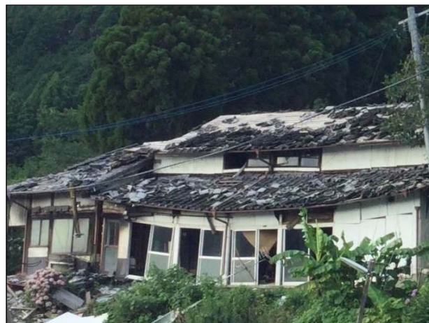
屋上仕上面全面にわたって大きな不陸、亀裂、剥落が見られる。
