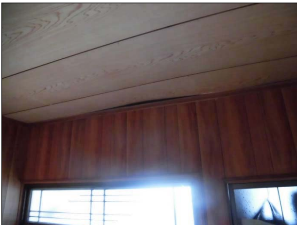
天井板の浮きが生じている。
