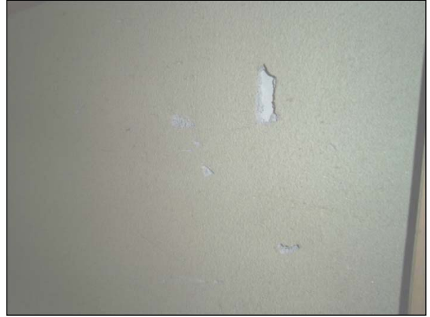
(衝突によりわずかな割れやへこみが生じている)
