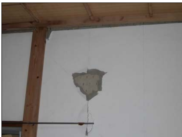
(衝突等により)クロスが破れている。
