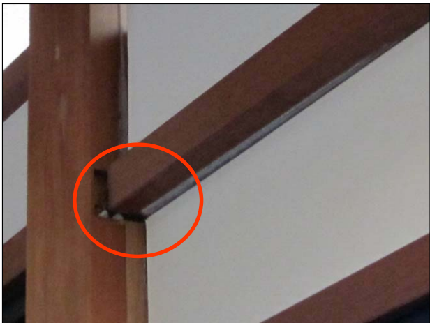
【在来工法】 柱と梁の仕口にずれが生じている。
