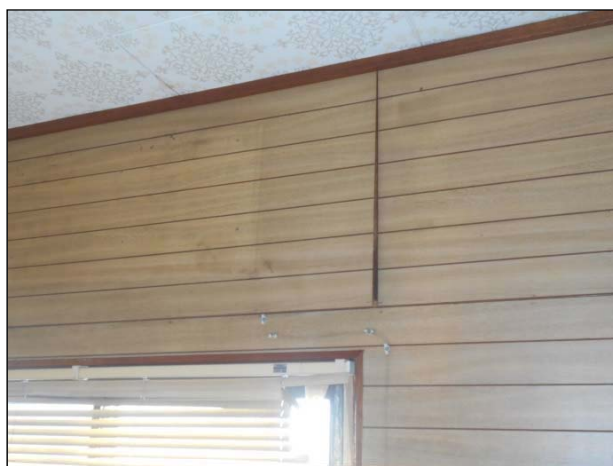
内壁合板にずれが生じている。
