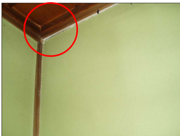
内壁周辺部に隙間が生じている。
