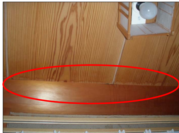
天井板に隙間が生じている。
