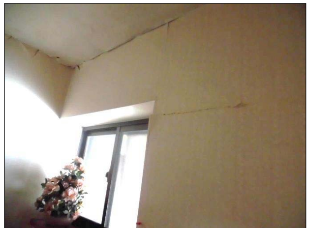
天井板に隙間が生じている。
