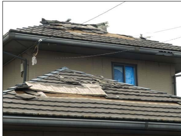
屋根の大半で多数の飛来物による衝突痕、突き刺さり、貫通痕がある。
