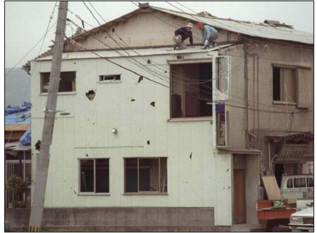
壁の大半にわたって飛来物による衝突痕、突き刺さり、貫通痕がある。
