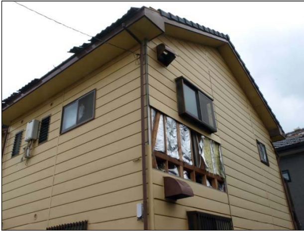
【ホード】 釘の浮き上がり、ボードの脱落が見られる。
