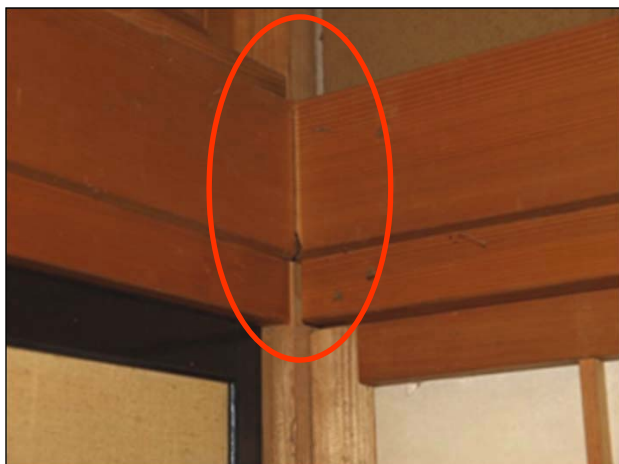
【在来工法】 柱と梁の仕口にわずかなずれが生じている。
