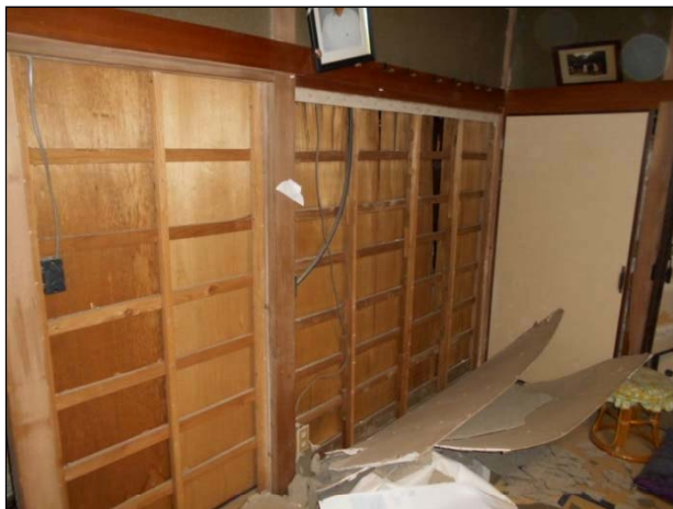
内壁合板に剥離、脱落が見られる。
