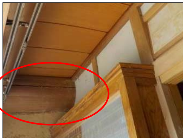
【在来工法】 柱、梁に割れが見られる。
