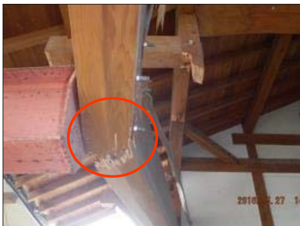
【在来工法】 柱、梁に著しい折損が生じており、交換が必要である。
