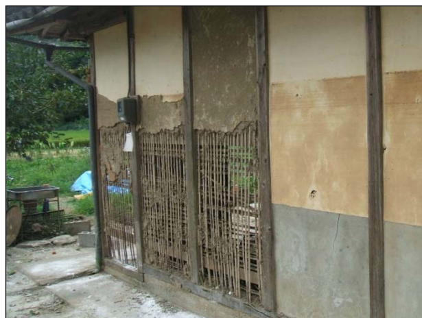
浸水により塗土の大半が剥離している。
