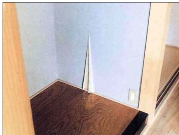
浸水により壁クロスの汚損・表面劣化・剥離等が見られる。 (下地材の交換を要しない程度)
