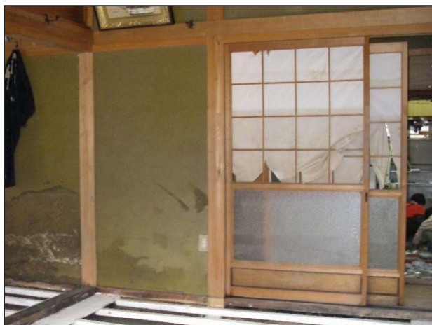
20094 【障子・襖】 浸水による襖・障子・ドアの破損(表面、格子・縁の洗浄、張り替えによって、再使用が可能な程度)
