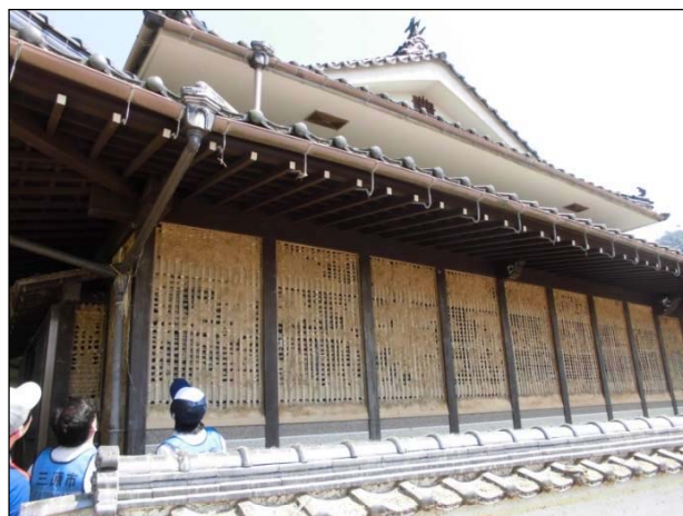
浸水により塗土の大半が剥離している。
