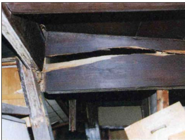
【在来工法】 柱、梁に折損が見られる。
