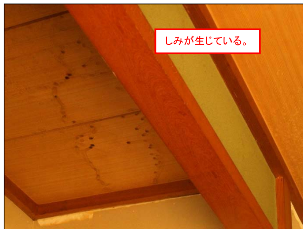
浸水による天井仕上(クロス等)の剥離・表面劣化が見られる。 (下地材の交換を要しない程度)
