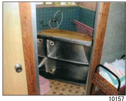
(浴槽 : 転倒し、配管が切れ再使用が不可能。
