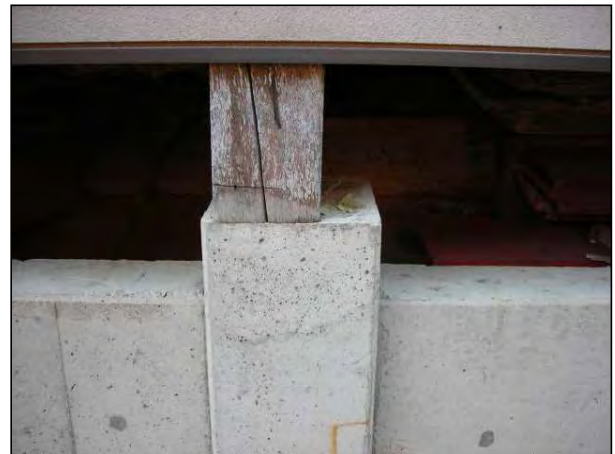
束が束石よりわずかにずれている。
