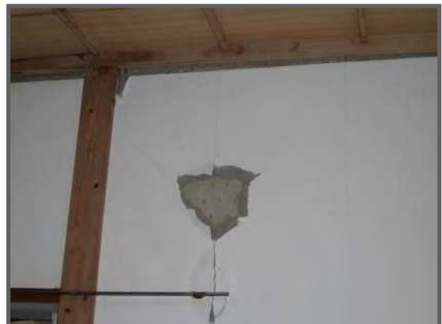
衝突等によりクロスが破れている
