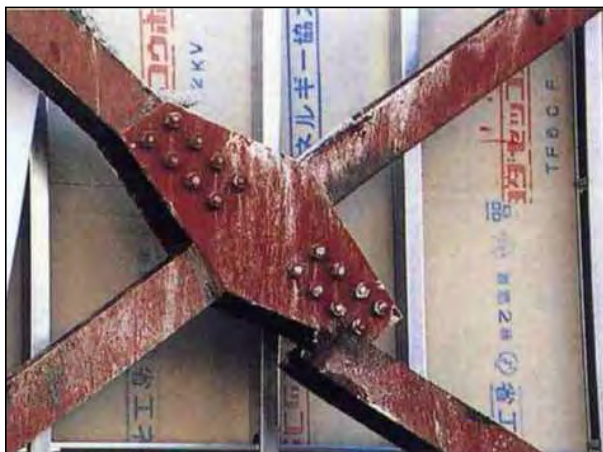
【鉄骨造】 破断が見られる。
