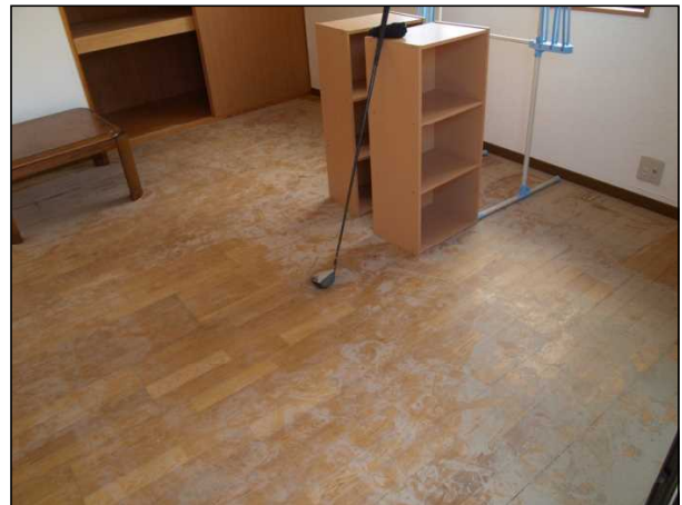
浸水により床板の汚損が見られる。
