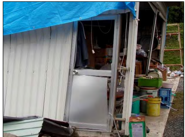
【アルミドア】 破壊されている。
