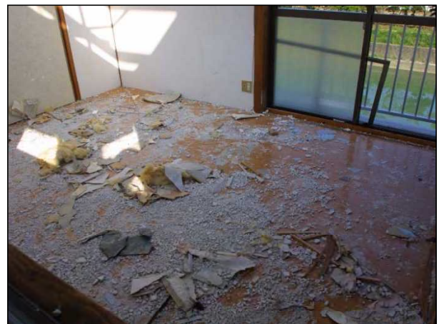
浸水により床板の汚損が見られる。
