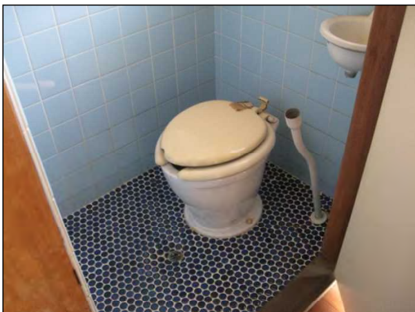
(便所・手洗い：配管が外れている。)
