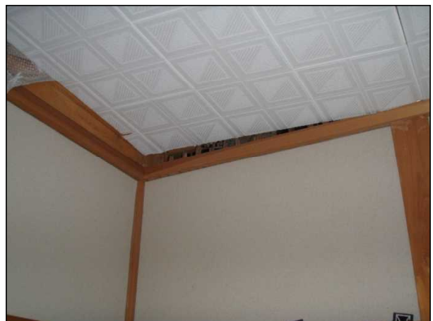
天井板の浮きが生じている。
