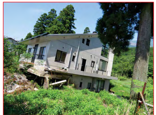
斜面崩壊により建物全体に傾斜が見られる。 12005
