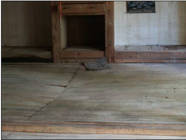
床板に著しい不陸、折損が見られる。
