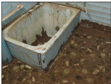
(浴槽：汚損し、配管が詰まっている。) 5301
