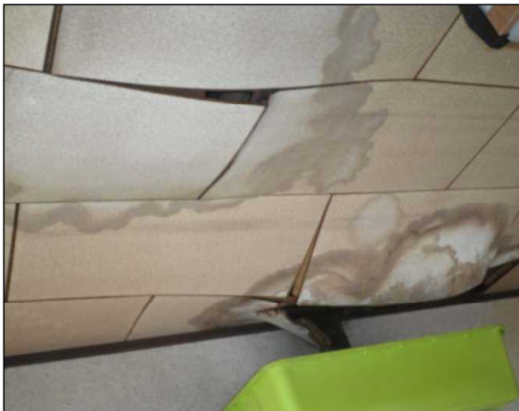
浸水による下地材・化粧せっこうボード・その他天井材の吸水・膨張・不陸等の機能損失が見られる。(下地材・天井板の交換を要する程度)
