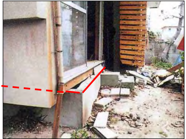
土台が基礎から著しくずれている。
