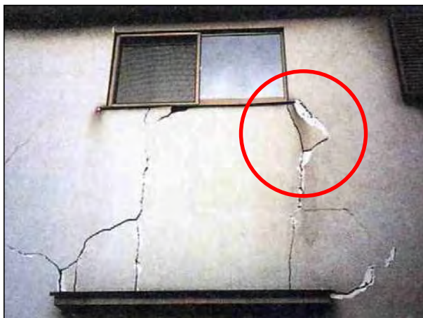
塗り壁の各所で仕上の脱落が生じている。
