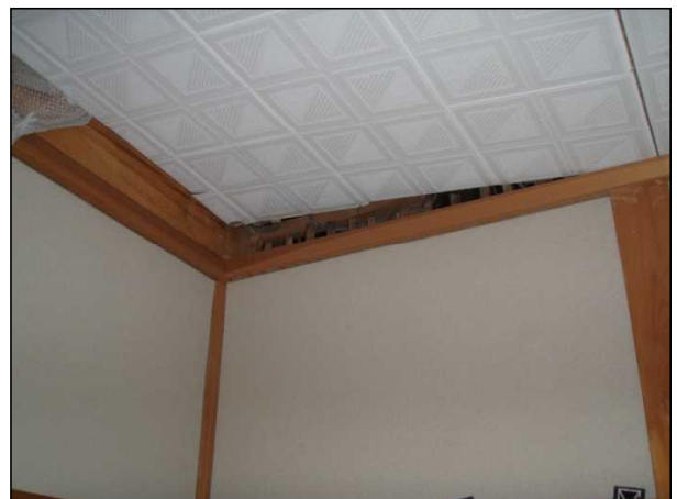
天井板の浮きが生じている。
