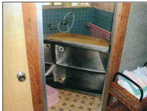
(浴槽：転倒し、配管が切れている。)
