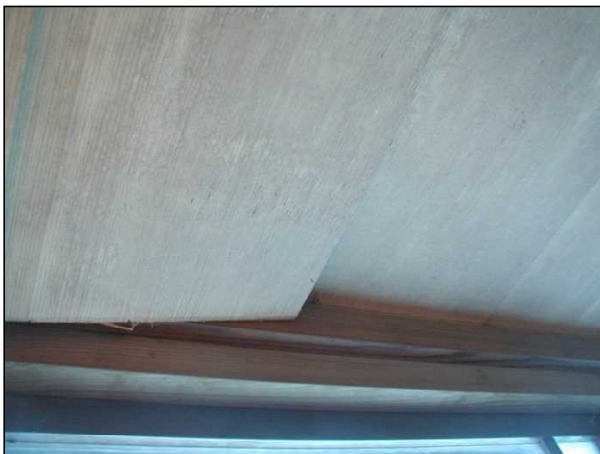
天井板の浮きが生じている。
