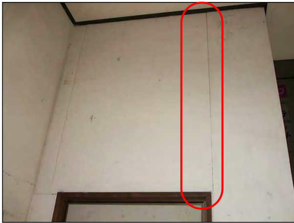
【内部仕上】 9501 ボードの目地部にわずかなずれが生じている。
