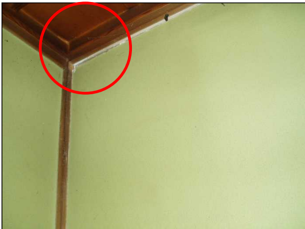
内壁周辺部に隙間が生じている。
