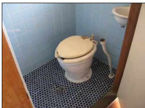
(便器、手洗いの配管が外れている。)
