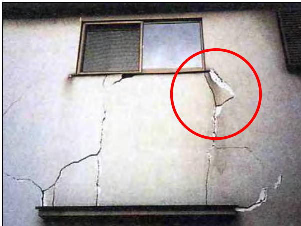
仕上の剥離が生じている。
