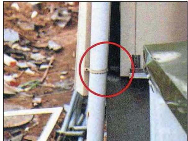
アンカーボルトの伸びが見られる。
