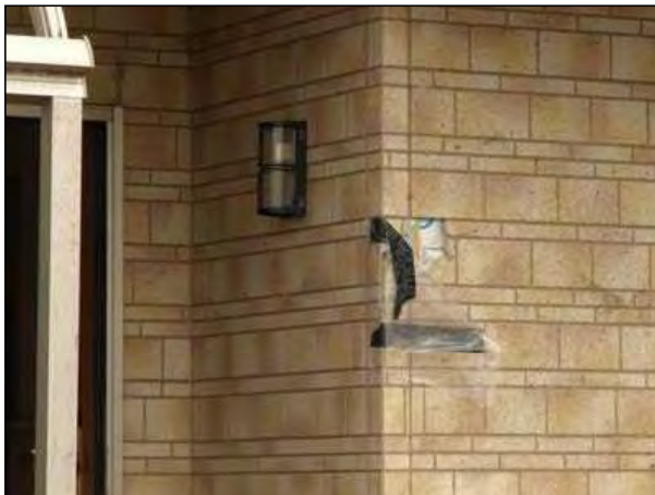
壁に飛来物の軽微な衝突痕がある。
