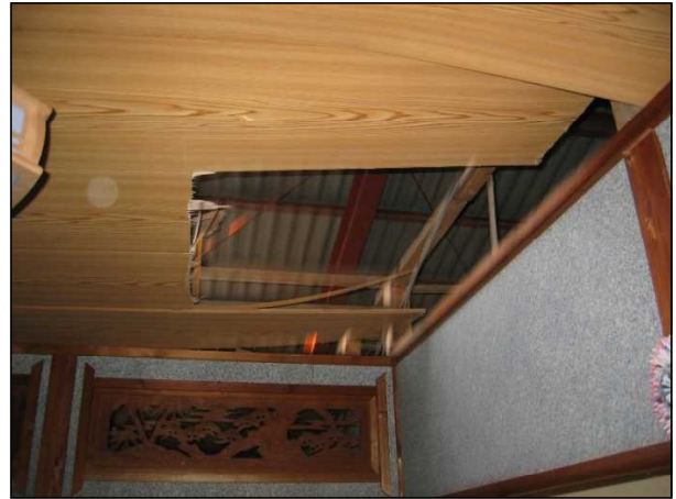
天井板のずれ、一部脱落が見られる。
