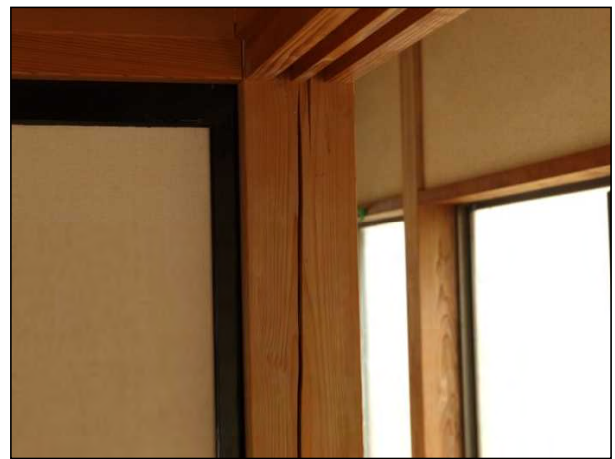
柱、梁に割れが見られる。
