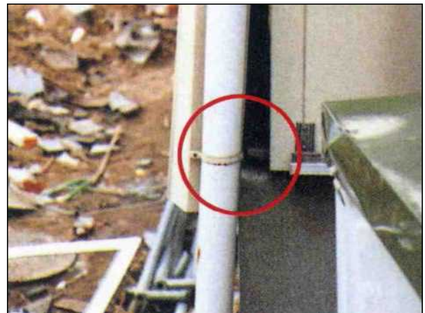
アンカーボルトの伸びが見られる。
