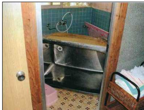
(浴槽：転倒し、配管が切れている。)
