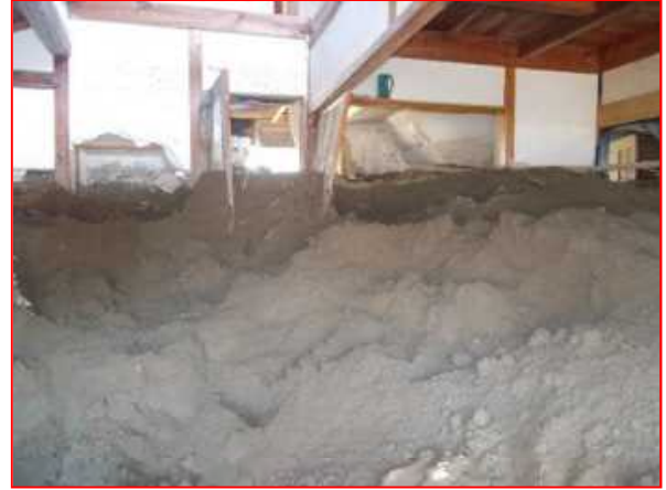
土砂等が住家及びその周辺に一樣に堆積している。 12007
