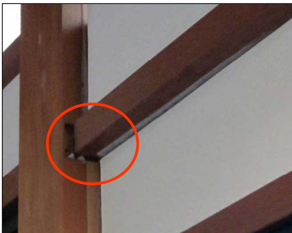
柱と梁の仕口にずれが生じている。
