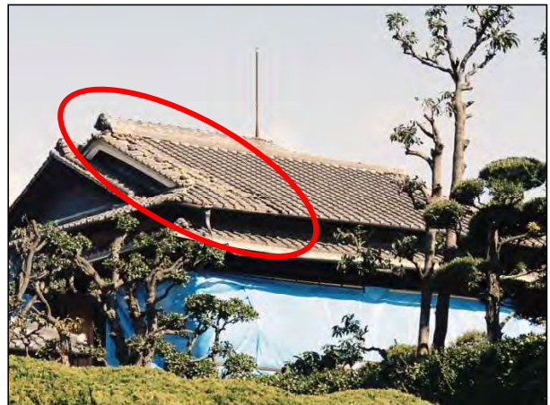
1506 棟瓦以外の瓦もずれが著しい。
