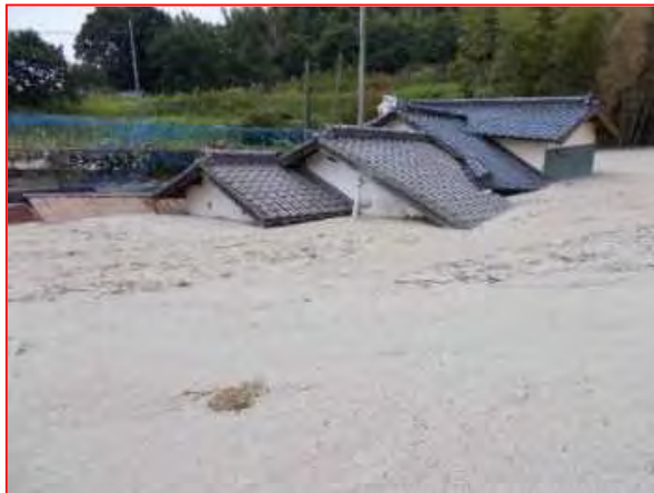
土砂等が住家及びその周辺に一樣に堆積している。 12006
