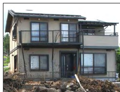
(ベランダ：外力等により変形している。) 5309
