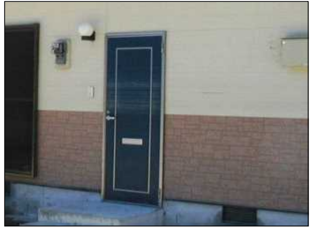
9702 【ドア】 浸水によるドアの破損(表面、格子・縁の洗浄によって、再使用が可能な程度)
