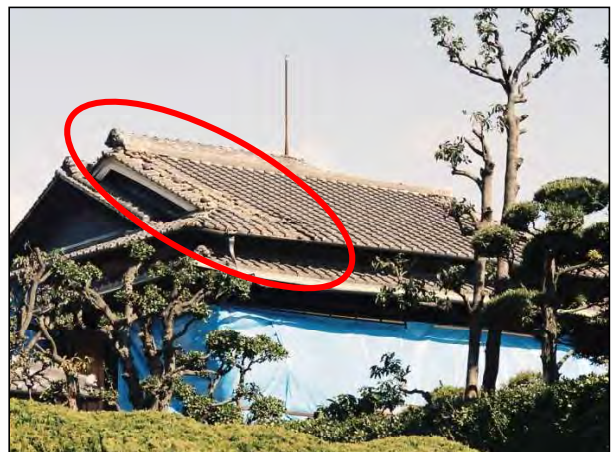
1506 棟瓦以外の瓦もずれが著しい。
