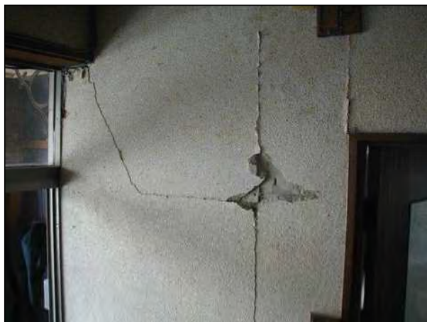
【内部仕上】 9505 クロスが破れている。
