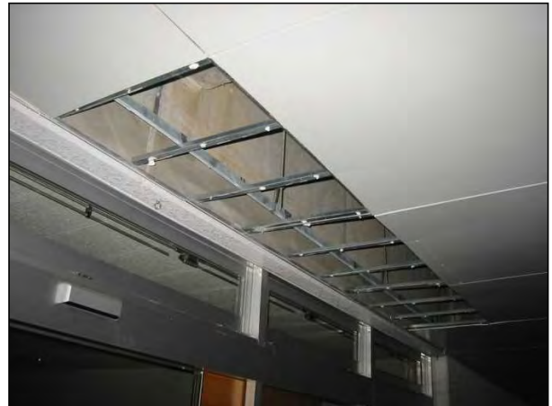
【天井】 9604 天井板が脱落している。
