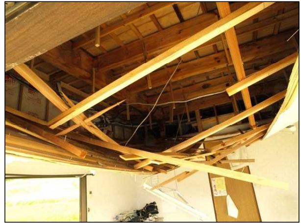
天井板が脱落している。
