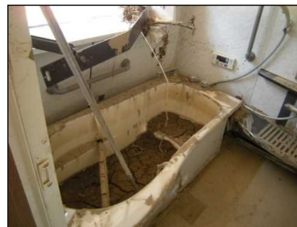
(泥流により使用できなくなった浴室) 5303
