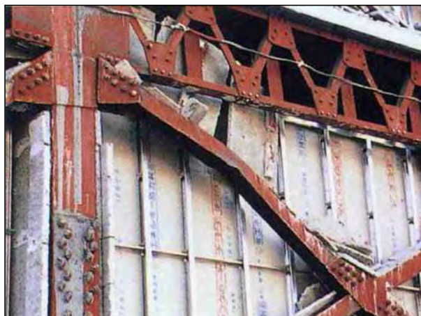
【鉄骨造】 座屈変形が見られる。
