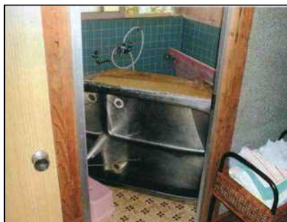
(浴槽：転倒し、配管が切れている。) 5302
