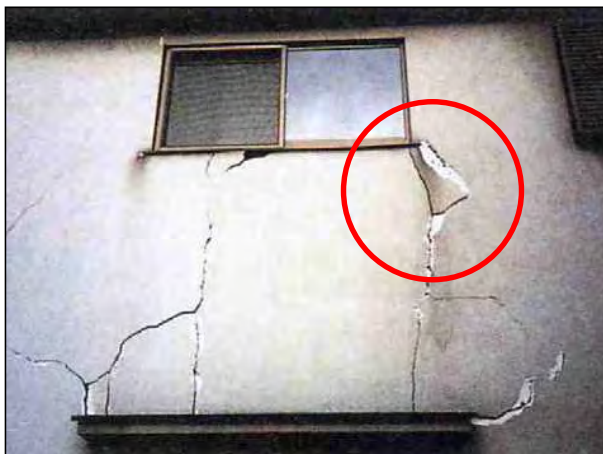
仕上の剥離が生じている。
