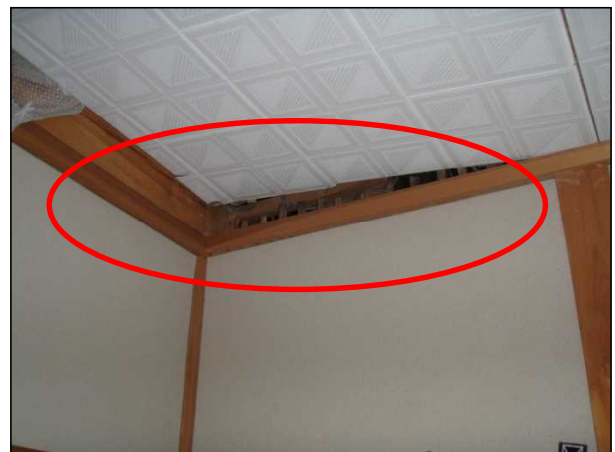
天井板の浮きが生じている。
