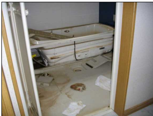
(浴槽：破損している。)
