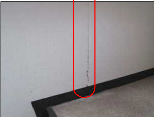
【内部仕上】 9503 ボードの目地部にひび割れやずれが生じている。
