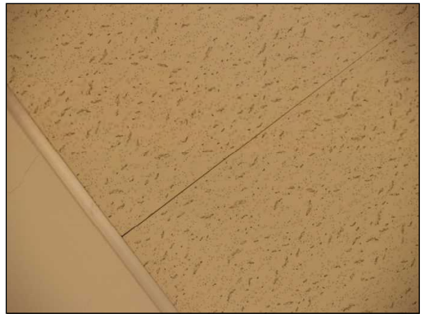
【天井】 9502 天井板にわずかな隙間が生じている。
