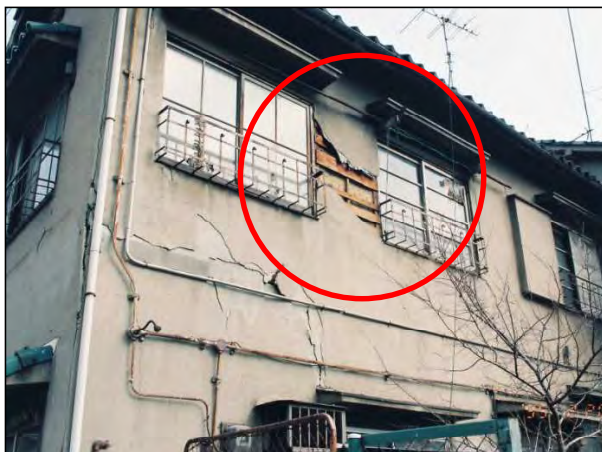
仕上材が脱落している。
