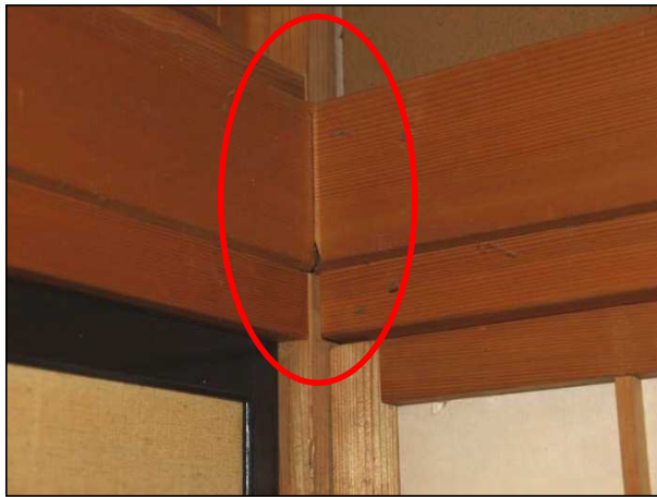
柱と梁の仕口にわずかなずれが生じている。
