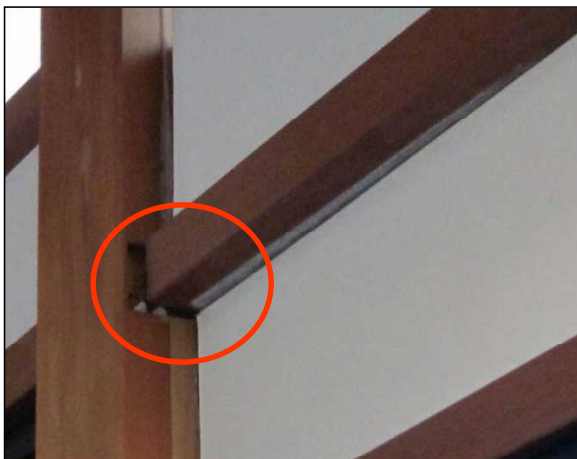
柱と梁の仕口にずれが生じている。
