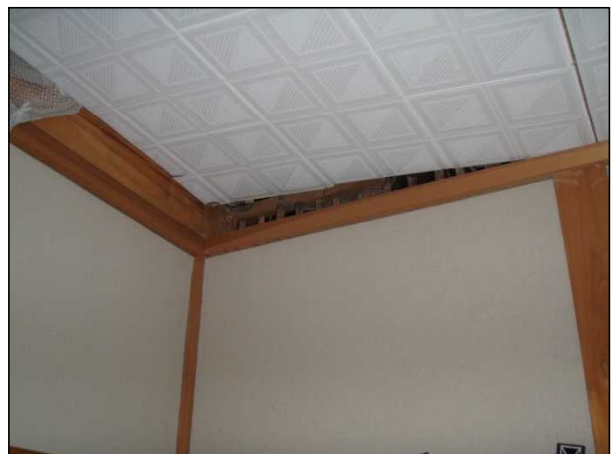
【天井】 9506 天井板の浮きが生じている。
