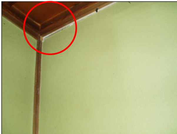
内壁周辺部に隙間が生じている。
