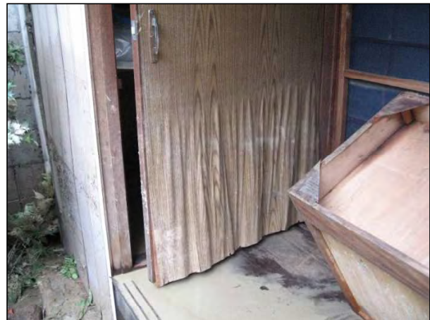
【ドア】 浸水によりドア等の面材が膨張し剥離している。 (再使用が不可能な程度)
