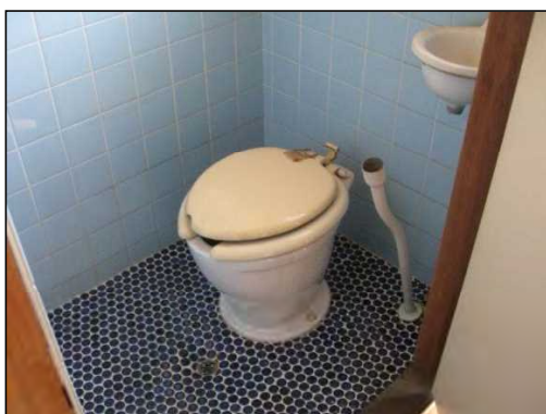
(便器・洗面：配管が外れている。)
