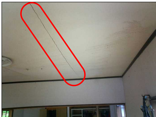
塗天井に亀裂が生じている。
