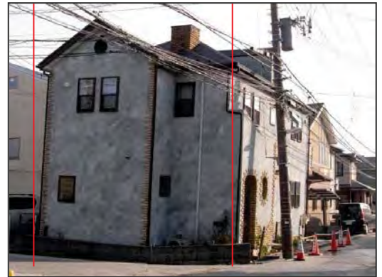
不同沈下による基礎・床も含めた傾斜が見られる。 110001
