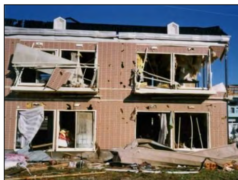
(ベランダ：手摺が破損している。)
