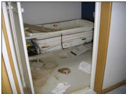
(浴槽：破損している。)
