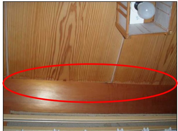
天井板に隙間が生じている。
