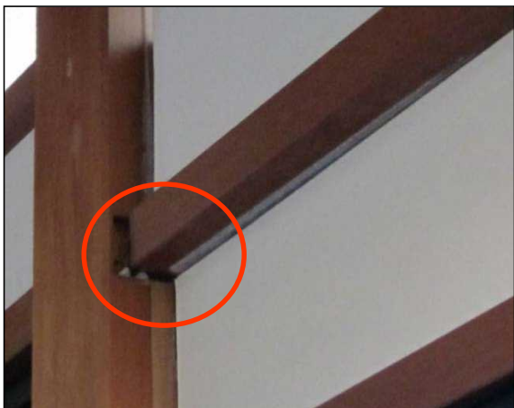
柱と梁の仕口にずれが生じている。
