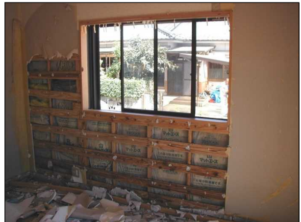
浸水により断熱材の吸水による機能損失が見られる。(再使用が不可能な程度)
