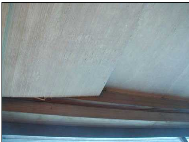
天井板の浮きが生じている。
