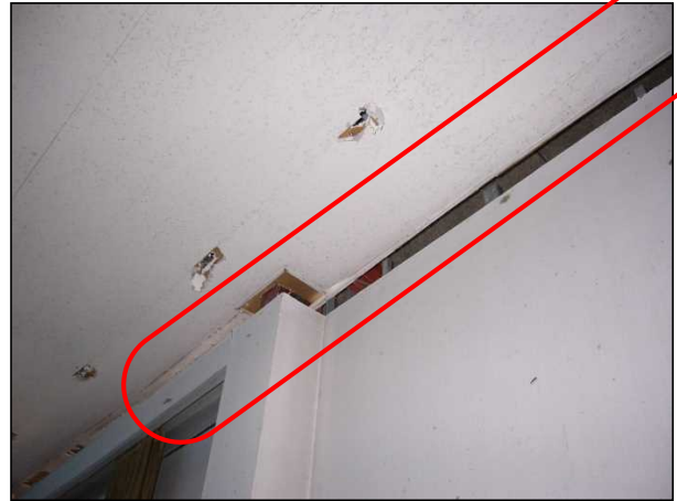
【天井】 9602 天井板のずれが見られる。
