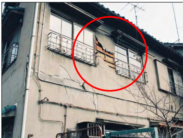
仕上材が脱落している。
