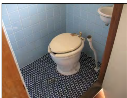
(便器：配管が外れている。) 5307
