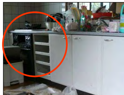
(システムキッチンのコンロ類が浸水により故障して使用不可能になっている。) 5306
