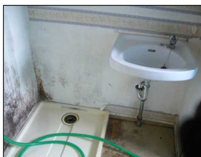
(洗面：汚損し、配管が詰まっている。) 5308
