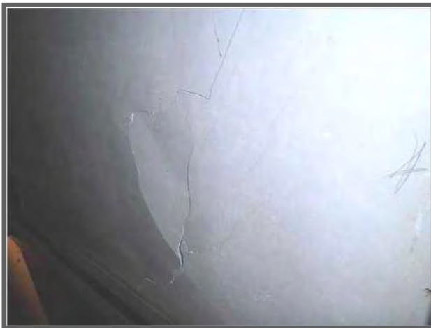
衝突によりへこみが生じている
