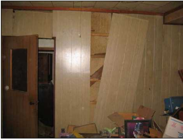
内壁合板に剥離、脱落が見られる。
