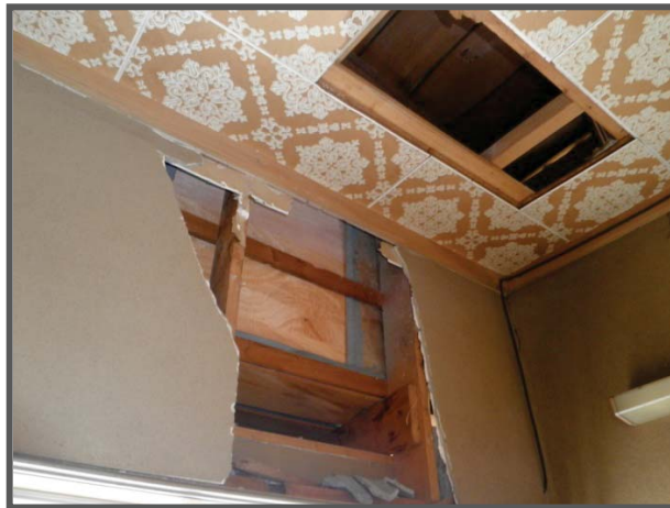
内壁合板に剥離、脱落が見られる
