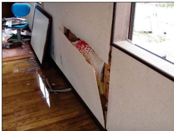
内壁合板に剥離、脱落が見られる。
