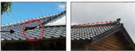
冷水により屋根瓦材が破損が認められる。
