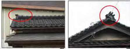
棟瓦(がらみ)が一部、のん瓦の一部がすれ、破損が生じている。
