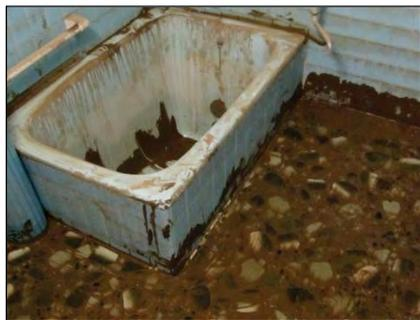
(浴槽：汚損し、配管が詰まっている。) 5301
