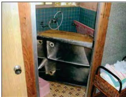
(浴槽：転倒し、配管が切れている。) 5302
