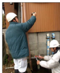
(住宅の傾斜の計測)
